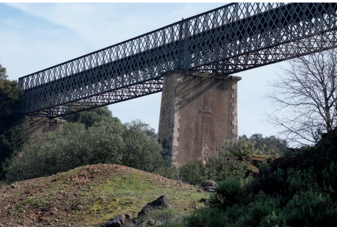
Puente de hierro sobre el arroyo Pedroches
