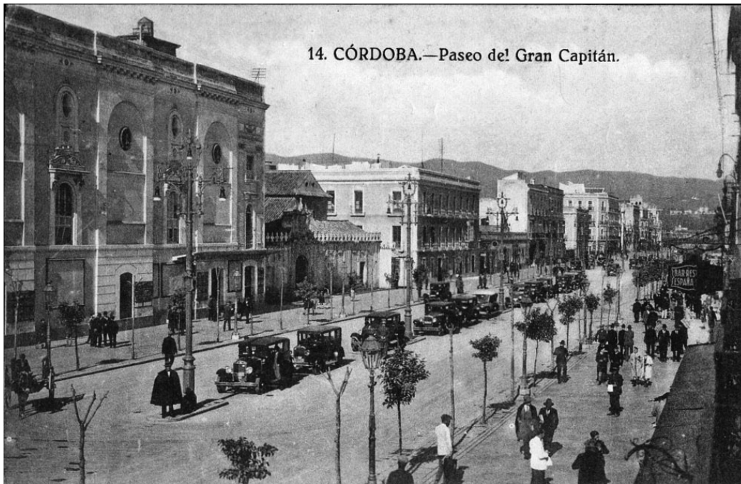
En esta antigua postal del Paseo Gran Capitán, podemos contemplar el Hotel Simón: Es el tercer edificio a la izquierda.
