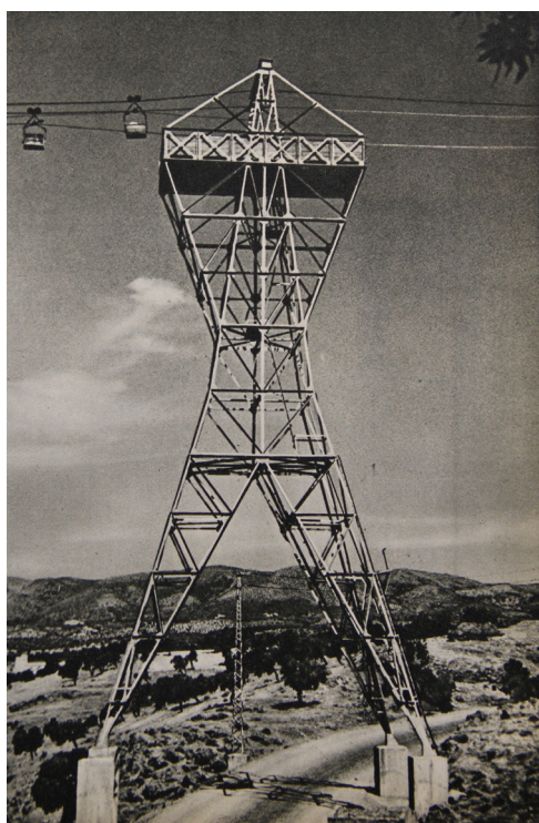
Torre que soportaba un cable de 1800 metros de longitud por el que circulaba las vagonetas procedentes de las canteras de Valdeazores y que cruzaba por encima de la CN 432 Badajoz-Granada 66 .
