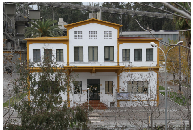
Estado actual del edificio de Oficinas (Foto: Jesús Padilla)
