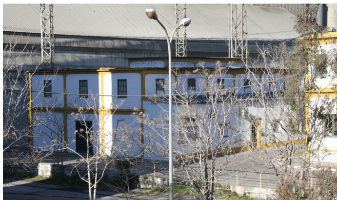
Antiguo edificio del almacén en la actualidad (Foto: J. Padilla)
