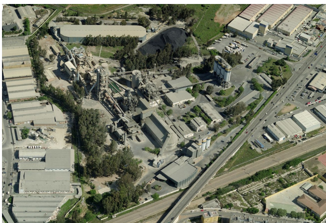
Vista aérea de la cementera (Google 2014)
