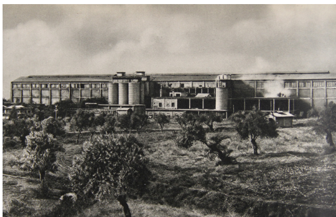
Vista general de la primitiva fábrica de Asland-Córdoba, S. A. (1931) 1
