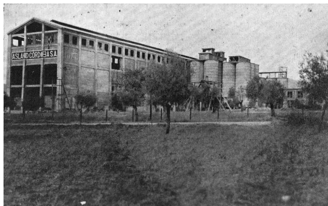
La fábrica de Asland Córdoba en construcción, vista desde el Sur-Este 77 .
