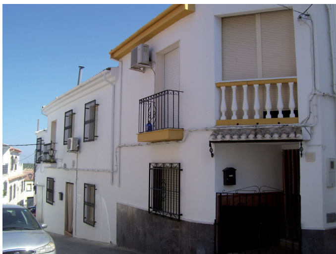
Lam.9. Puesto de Castil de Campos (en la calle Fuente-Tójar.)
