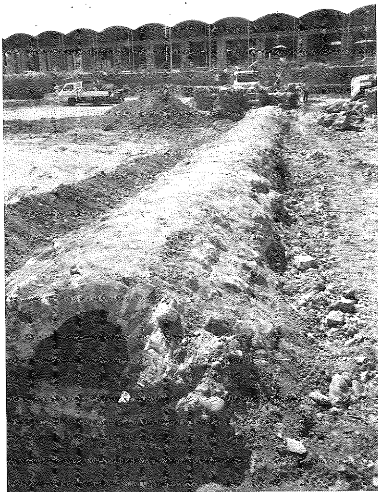
Lám. 9. Detalle de la cubierta contemporánea (inicios del s. XX) del Acueducto 1.
