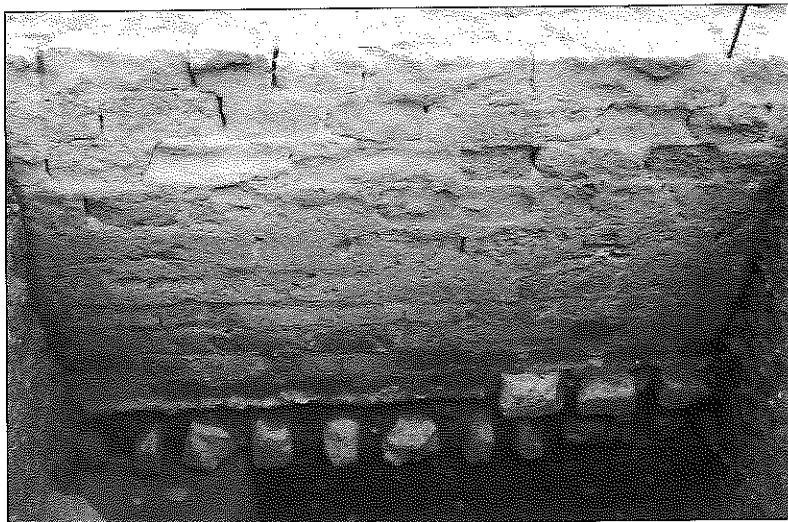
Cimiento de la muralla bajomedieval en avenida de las Ollerías nº 14.
