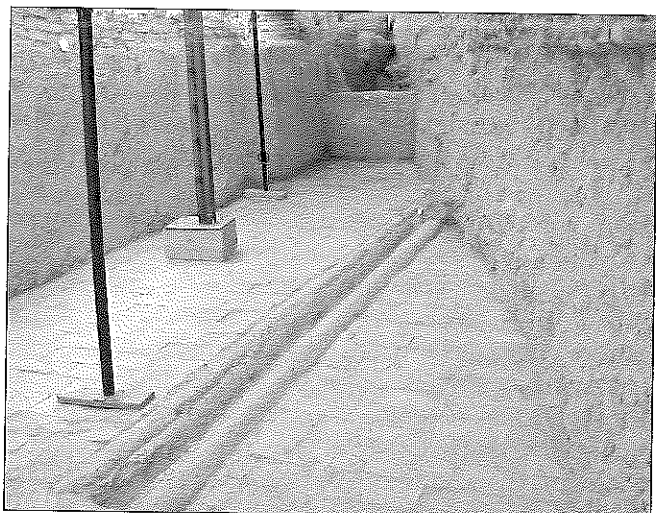
Lám. V. Interior de una cisterna. El muro de la izquierda, de opus latericium enfoscado de estuco, corresponde al cierre norte y conserva una altura casi de 2 m., el muro de la derecha es el cimiento de la villa bajo la que se introducen las instalaciones termales. El pavimento de ladrillo y el canal central son consecuencia de una refacción del aljibe para su utilización posterior, no como continente de agua.
