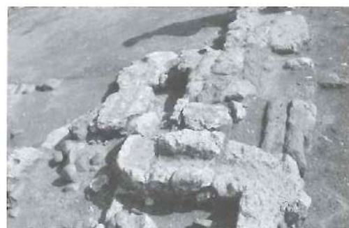
Lámina 22. Canaillo en recodo de la Casa 61, Man. J, detalle del desagüe.
