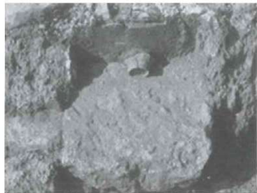
Lámina 20. Alberquita de la Casa 50, Man. J, detalle del desagüe.
