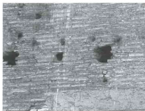
Figura 16: Detalle de los agujeros para la sujeción de las lastras marmóreas de la Forma.
