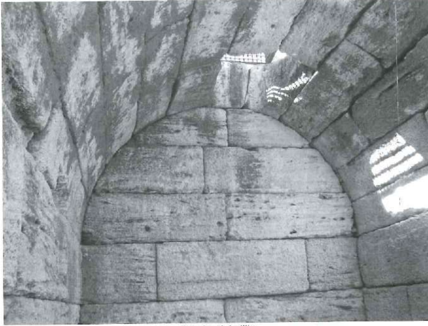
Interior del aljibe
