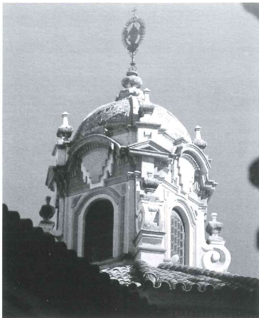
Linterna de la cúpula de la Capilla de la Asunción
