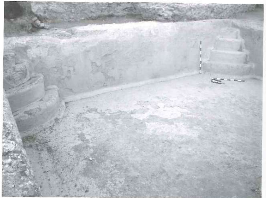
Figura 4: Escaleras de la natatio del edificio termal
