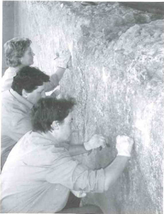
Figura 3: Trabajos de limpieza mural
