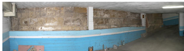
Resto de la muralla existentes en el sótano de la casa número 36 de la Plaza de Colón
