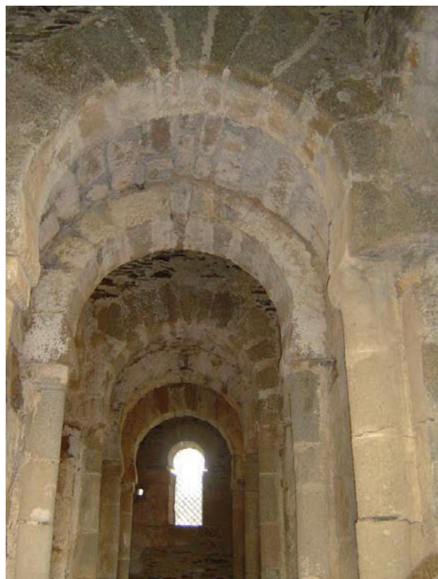
Vista del transepto, con alternancia de arcos y bóvedas intermedias (Fotografía del autor)
