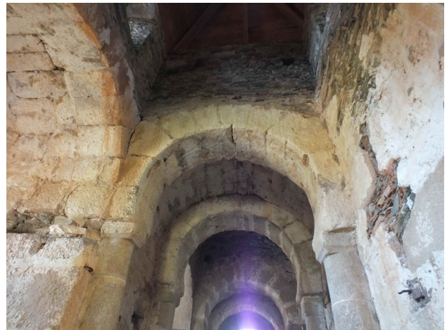
Vista de arcos y bóvedas de Santa María del Trampal
