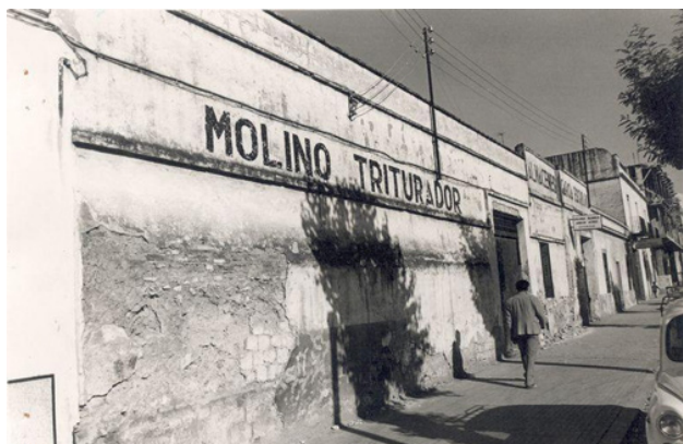
Fotografía del edificio de la Plaza de Colón nº 29, antes de su demolición (Fototeca Municipal, 1971)
