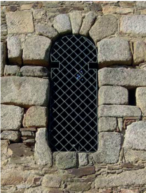
El friso continúa su recorrido por los muros testeros hasta los huecos, manteniéndolo por las jambas y apareciendo al exterior donde se prolonga hacia ambos lados (Fotografía del autor)
