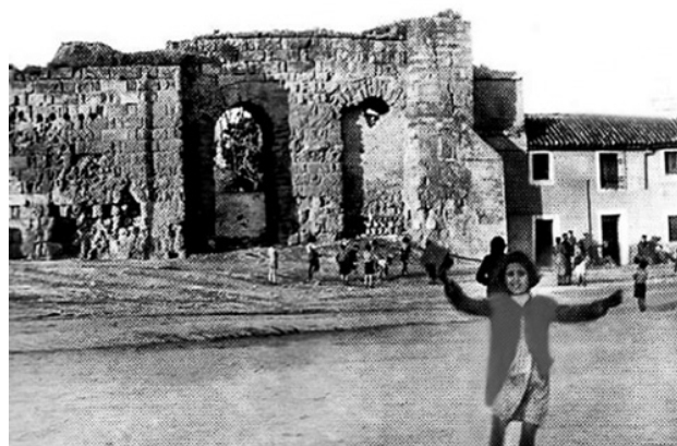
Torre albarrana en Puerta Sevilla
