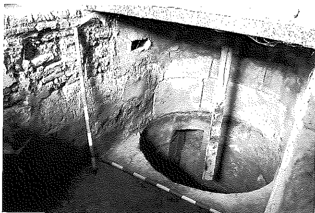
Fig. 15. Vista del pozuelo y palahierro de la piedra de moler instalada en la Aceña Chica y de la inscripción grabada en el muro meridional de dicho espacio (Foto: R. Córdoba).
