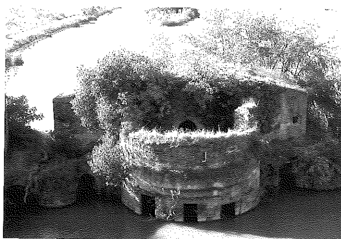
Fig. 17. El molino de San Rafael fue edificado en 1844 sobre los restos del antiguo molino del Duende, al que podría pertenecer la zona en forma de ábside que enfrenta a la corriente, característica de las antiguas aceñas. (Foto: R. Córdoba).
