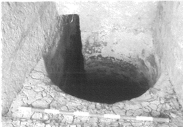
Fig. 7. Pozuelo y saetilla del molino de San Antonio, junto a la Calahorra (Foto: R. Córdoba), y representación de un rodezno girando en su pozuelo, en el manuscrito Los Veintiún Libros , del siglo XVI.
