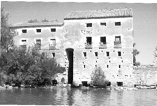
Fig. 12. Aunque los pisos superiores del molino de Lope García son de construcción decimonónica, las dos crujeas que albergan nueve piedras de regolfo en su interior constituyen la obra original que transformó las antiguas aceñas a fines del siglo XVI (Foto: R. Córdoba).
