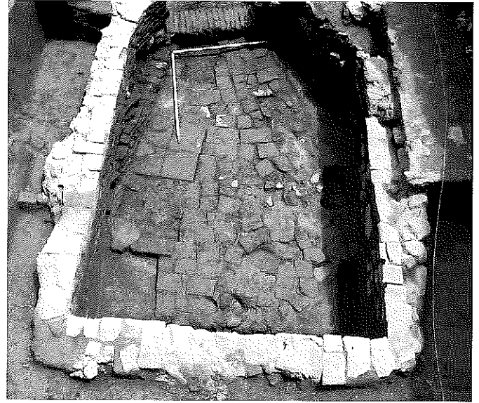
Lámina 5. Pavimento de losas de ladrillo rectangulares fragmentados por la mitad con losas de ladrillo cuadradas.
