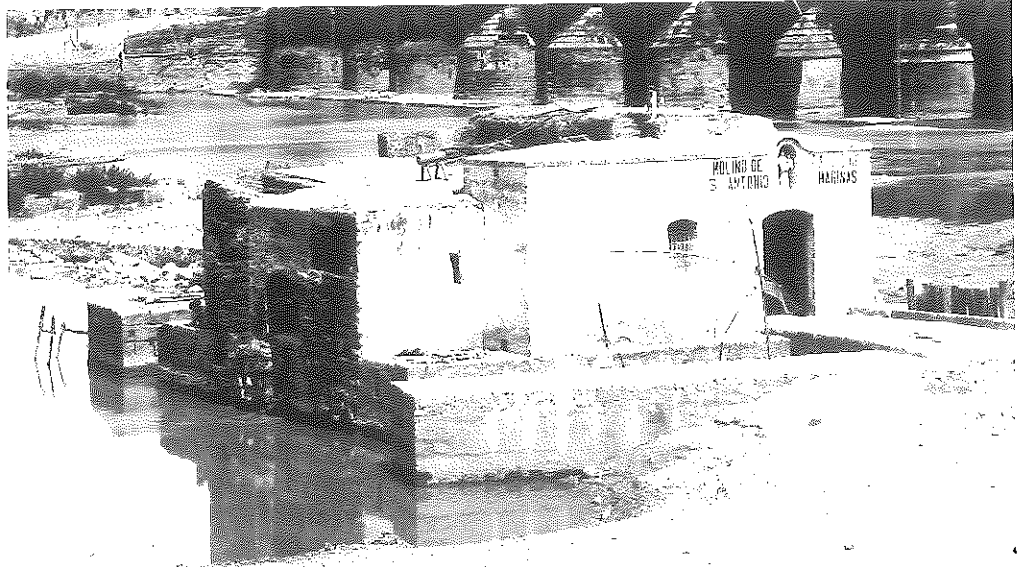
Fig. 14. El molino de San Antonio en torno al año 1900, cuando contaba ya con las cuatro piedras de regolfo que hoy conserva, aunque no se había edificado aún el piso superior (Archivo Municipal de Córdoba).
