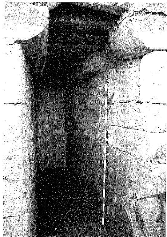
Fig. 6. Canales de regolfo en los molinos cordobeses de Lope García y San Antonio (Foto: R. Córdoba).
