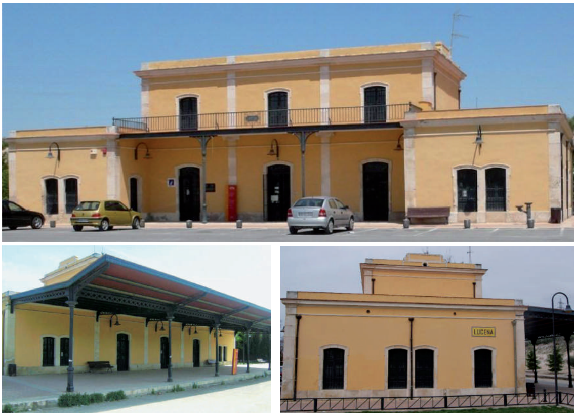
Fig. 5. Edificio de viajeros en la estación de Lucena. Fotografía inferior derecha: A. Moreno (2012)
