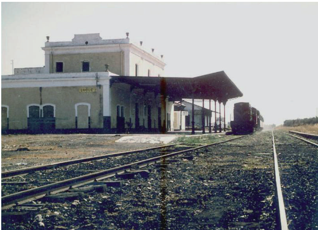
Fig. 8. Vista posterior del edificio de viajeros en la estación de Luque. Fotografía tomada desde las vías en la década de 1970
