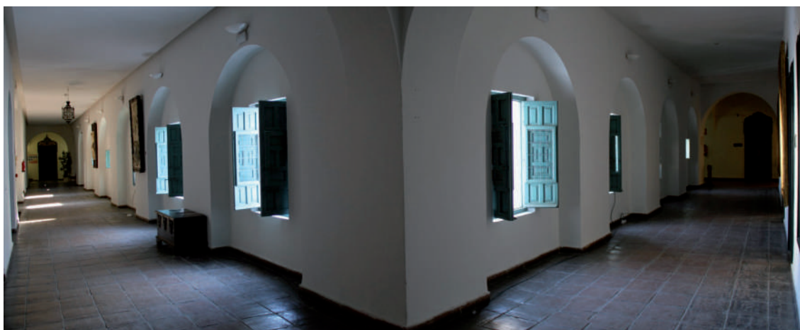
Interior de la galería superior del Patio Blanco en donde se aprecia clarísimamente los arcos primitivos cerrados por tabiques y en medio de ellos las ventanas abiertas (Foto: J. Padilla)
