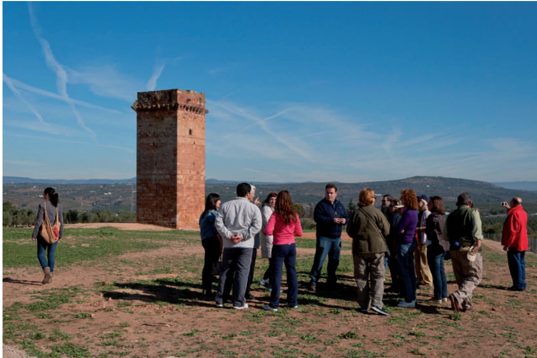
Torre de Villaverde
