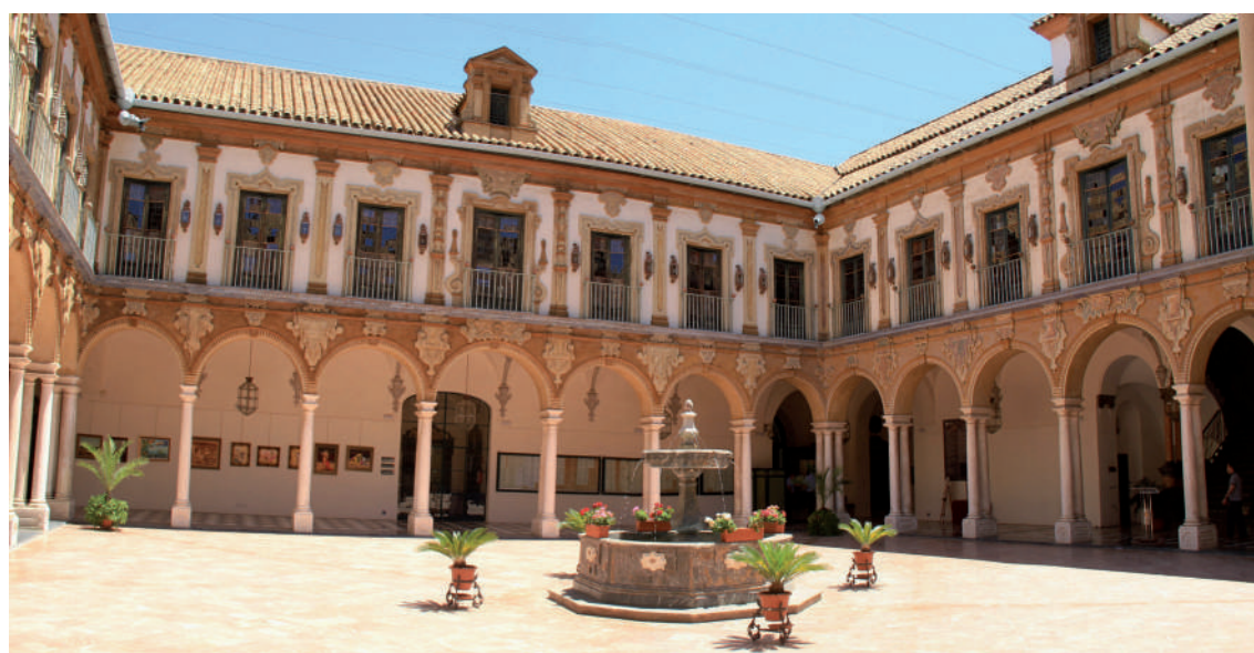
Vista actual del Patio Barroco donde podemos apreciar la colocación de los actuales maceteros que adorna dicho patio
