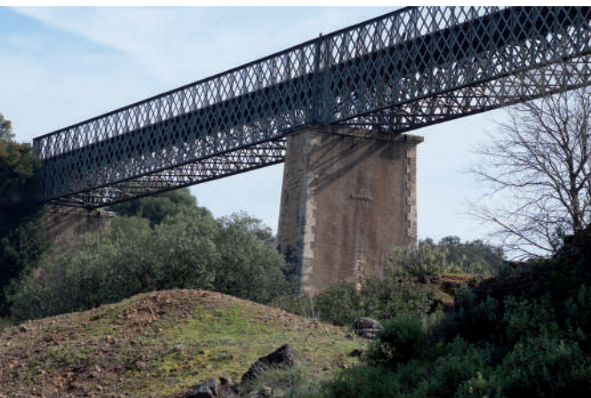
Puente de hierro sobre el arroyo Pedroches
