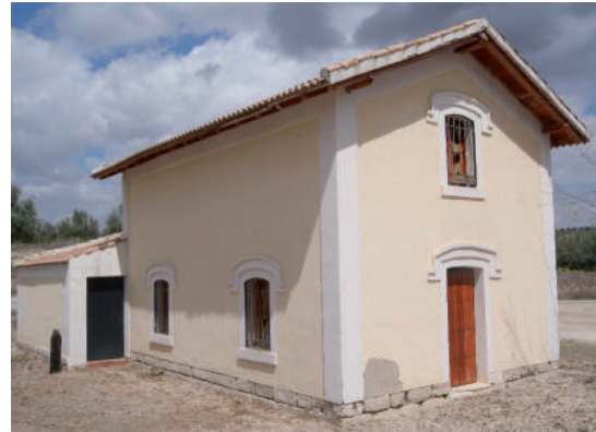
Fig. 13. Caseta ferroviaria en el paraje de las Cruces (Luque). Foto: A. Moreno, 2012
