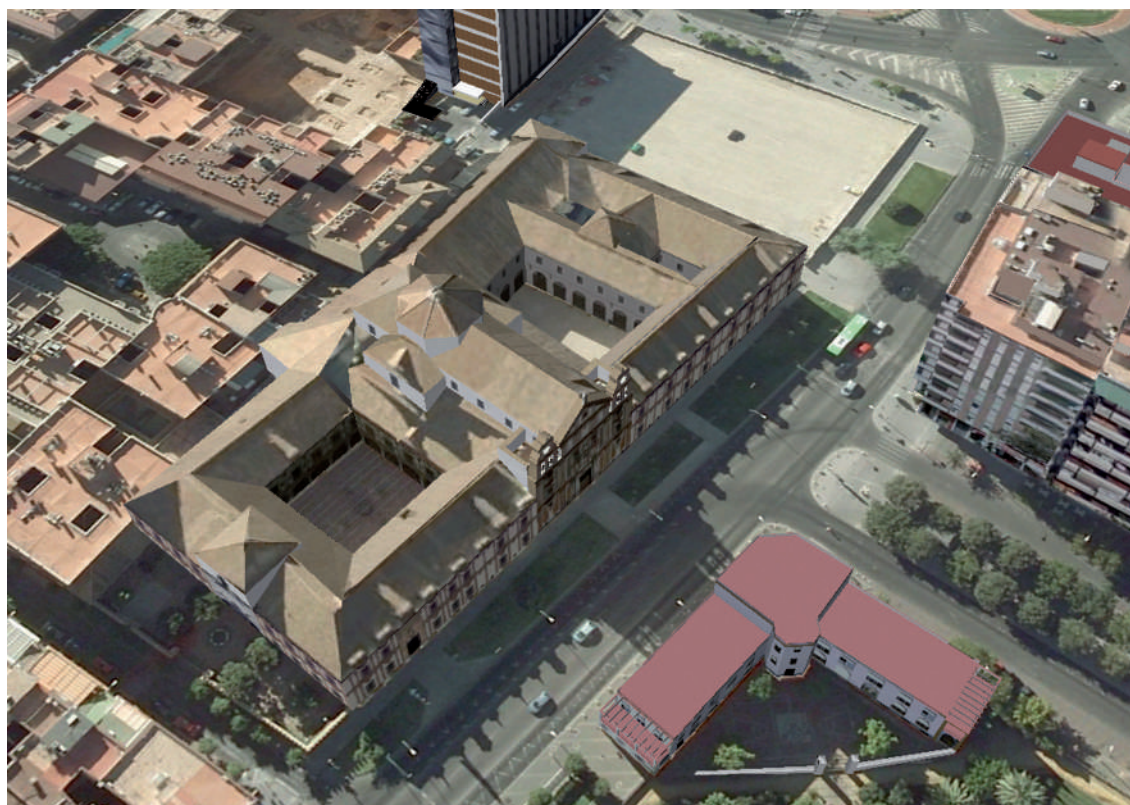
Vista aérea del Palacio de la Diputación (Google earth, 2013)
