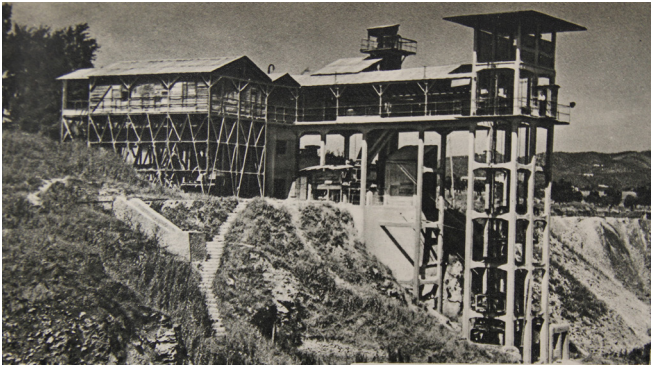
Estación del teleférico en las canteras 65
