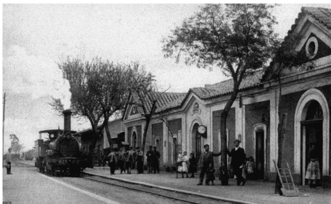
Estación de Peñarroya (Postal de Louis Rabouin)
