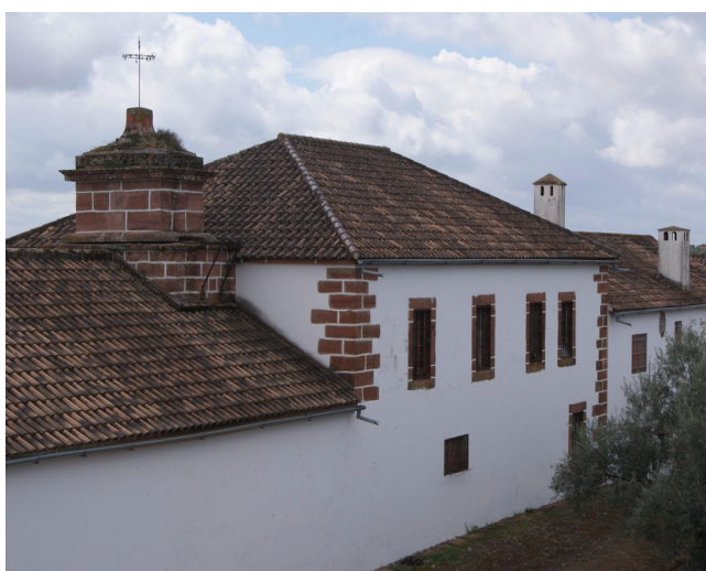
En la Casería de Isasa: nave de almazara con prensa de torre, junto a la bodega y el señorío (Foto: A. Moreno)
