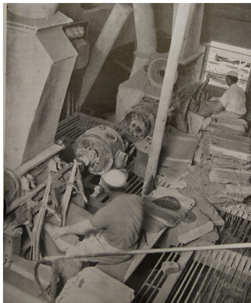
Detalle de la nave envasadora de la fábrica de Cemento (1964) 76
