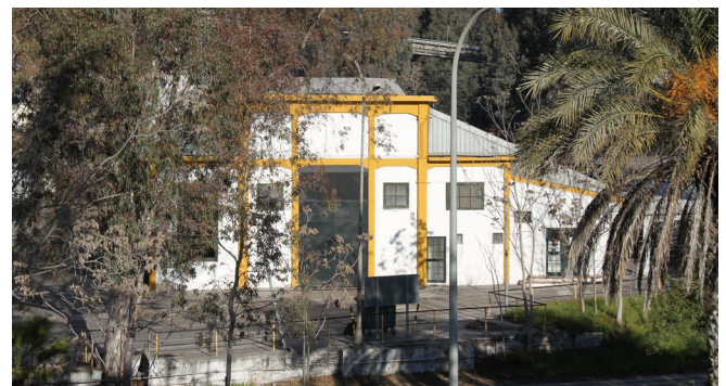
Edificio de talleres en la actualidad (Foto: J. Padilla)
