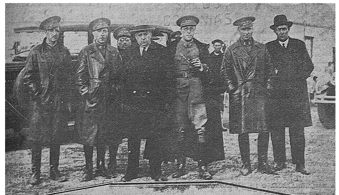
Comisión técnica militar, que acompañada por el alcalde Francisco de la Cruz Ceballos visitó la fábrica de cementos Asland el 26 de febrero de 1932 invitados por Antonio Carbonell Trillo-Figueroa 120 .
