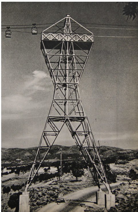
Torre que soportaba un cable de 1800 metros de longitud por el que circulaba las vagonetas procedentes de las canteras de Valdeazores y que cruzaba por encima de la CN 432 Badajoz-Granada 66 .
