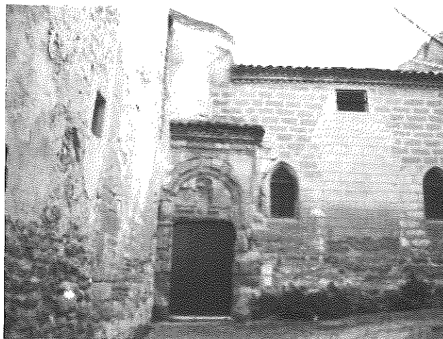
Antiguo postigo situado en la fachada NE de la iglesia
