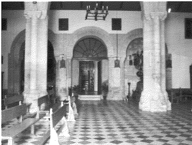
Fotografía de los tres arcos hechos con sillares de piedra adovelados
