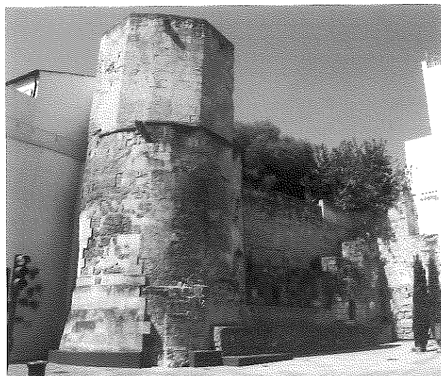
Restos de la murallas de la puerta del Rincón: al fondo, la cerca medieval sobre la que se asentaba la puerta y el torreón denominado “Mirador de los Capuchinos” y primer plano la torre de origen romano que cerraba el ángulo nororiental de la ciudad, sobre la que se eleva un recrecido medieval
