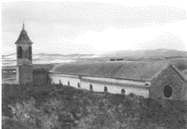
Vista de la fachada lateral posterior de la Parroquia del Soterraño donde se aprecia un bello rosetón
