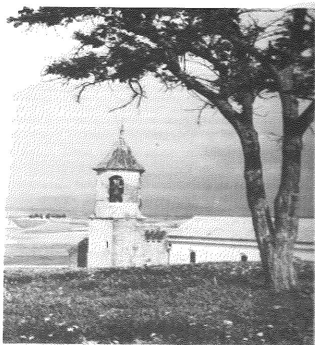
Torre de la iglesia de Nuestra Señora del Soterraño
