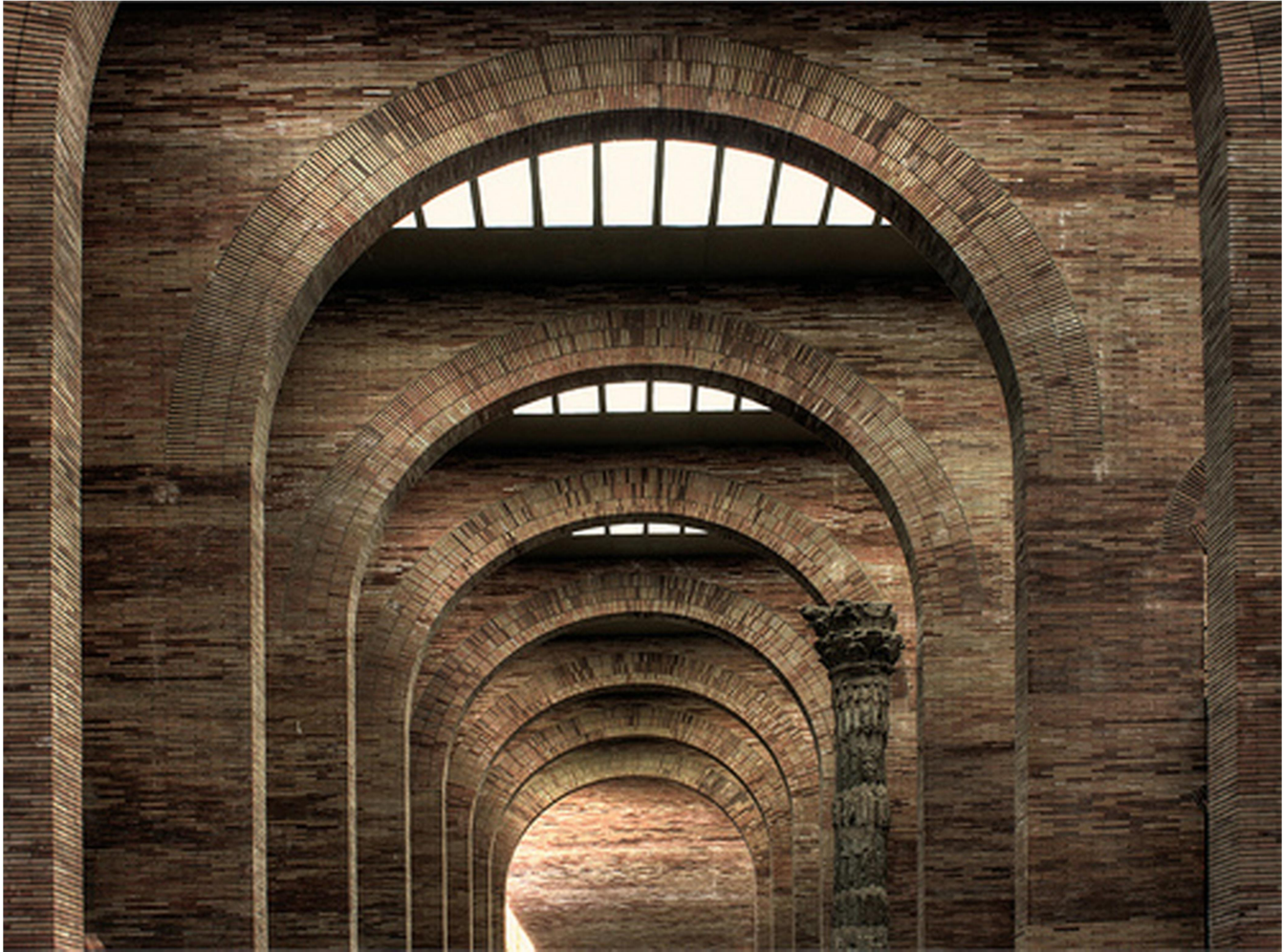
Planta baja, detalle de la arquería
