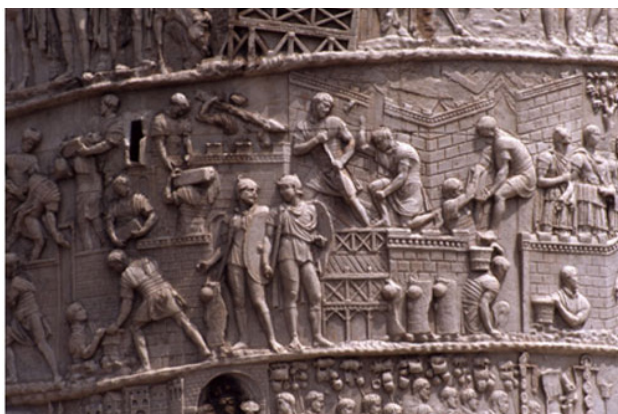
Relieve de la Columna Trajana (Roma, Italia). En esta escena se pueden ver como los legionarios también realizaban tareas de construcción en los campamentos militares
