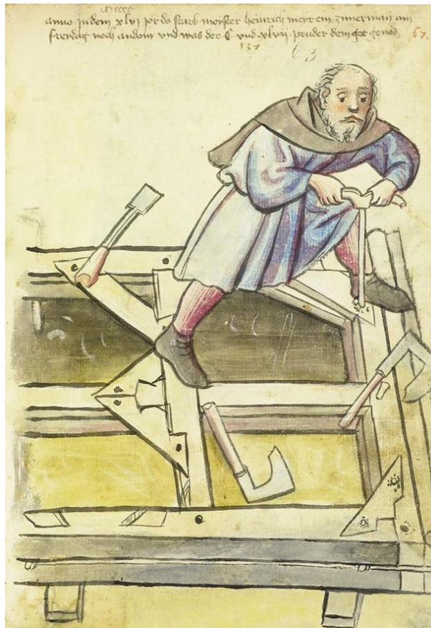
Carpintero montado en un marco fabrica el bastidor de una estructura<sup>142</sup>
