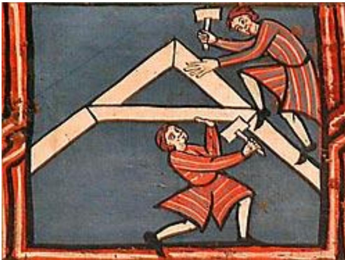
Dos operarios con mazas montando la estructura de par y nudillo de la techumbre. Mientras uno acopla la unión de los pares, el otro sujeta el nudillo y ajusta su unión con el par sobre el que está su compañero.
