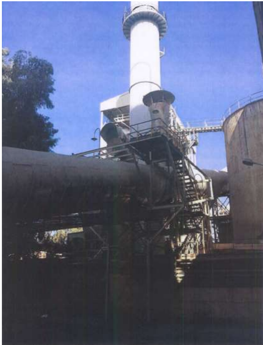
Conducto de gases entre ventilador K03 y sección de crudo.
