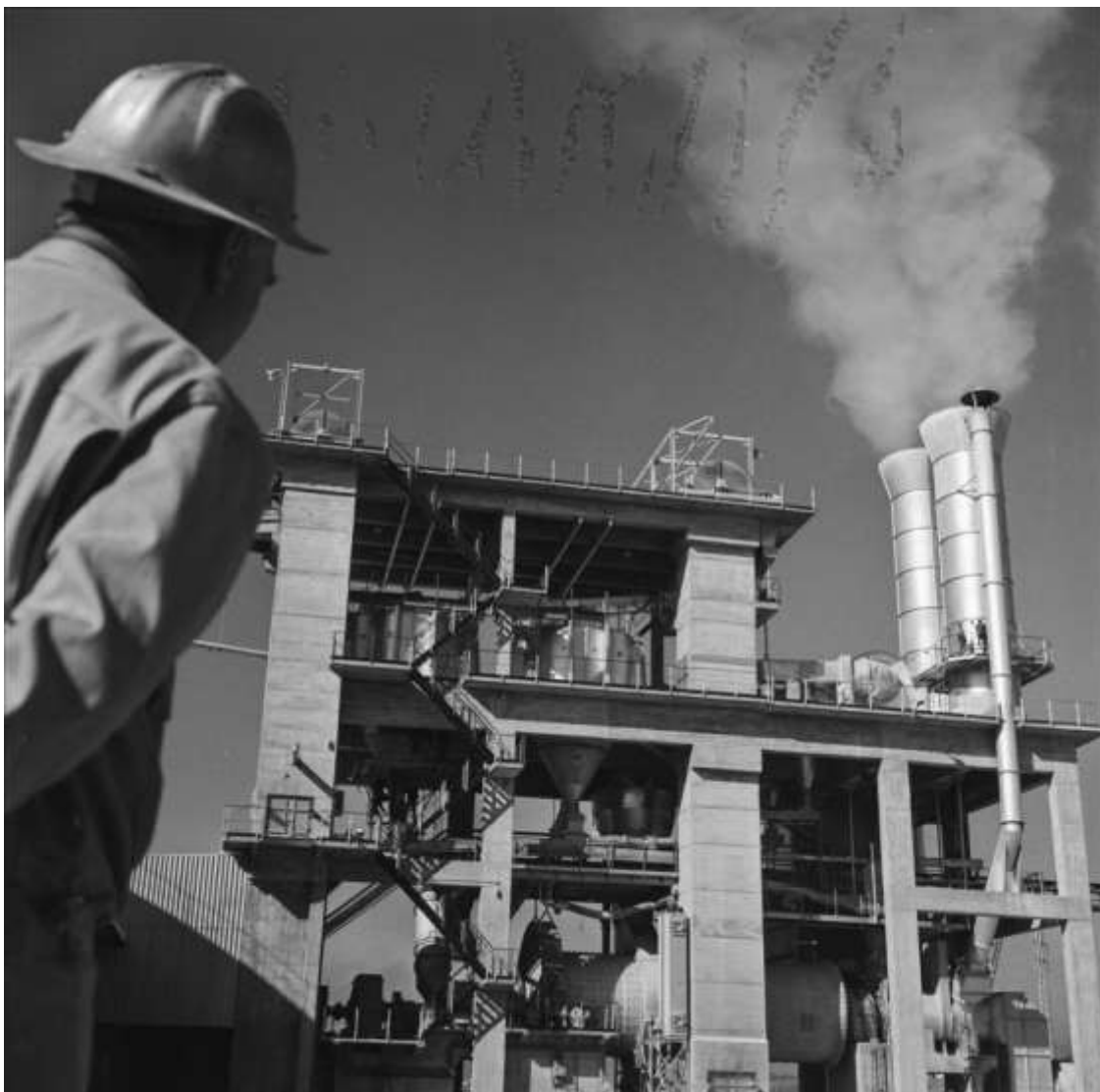
Vista general de las instalaciones de la cementera Asland de Córdoba (Foto: Juan Miguel Pando Barrero (1915-1992), fechada el 5 de abril de 1966) 95 .
