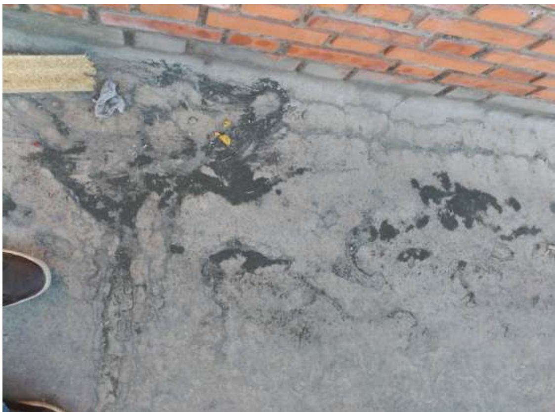
Restos del polvo denunciado existente sobre el acerado de la Avda. de Chinales.
