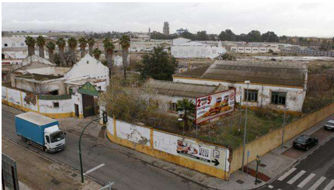
Terrenos de Chinales, donde Kronos Homes ha iniciado la construcción de una importante promoción de viviendas (Foto: Valerio Merino, ABC , 14 de enero de 2018)
