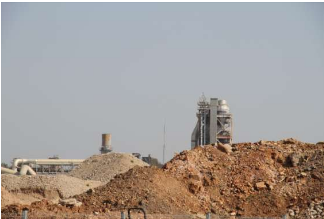
Vista de la cementera desde el solar de Kronos Homes en C/ Fuente de la Salud. Donde hoy hay montones de tierra, mañana habrá viviendas (Foto: J. Padilla de 21 de febrero de 2019)
