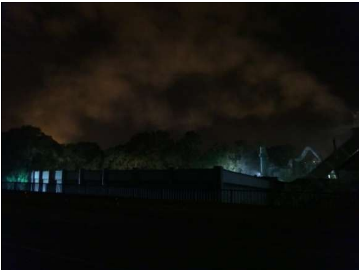
Foto de la cementera realizada el 8 de septiembre del 2018
