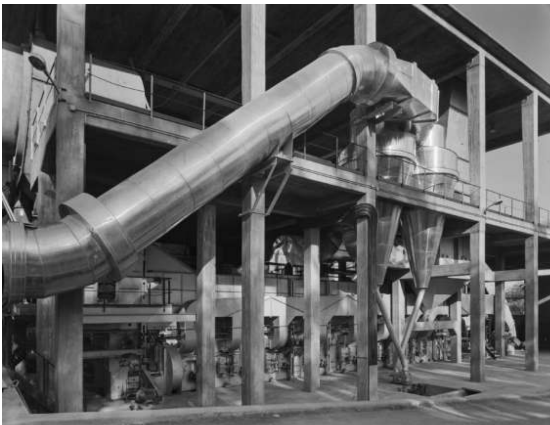
Vista general de las instalaciones de la cementera Asland de Córdoba [Foto: Juan Miguel Pando Barrero (1915-1992), fechada el 4 de abril de 1966] 58
