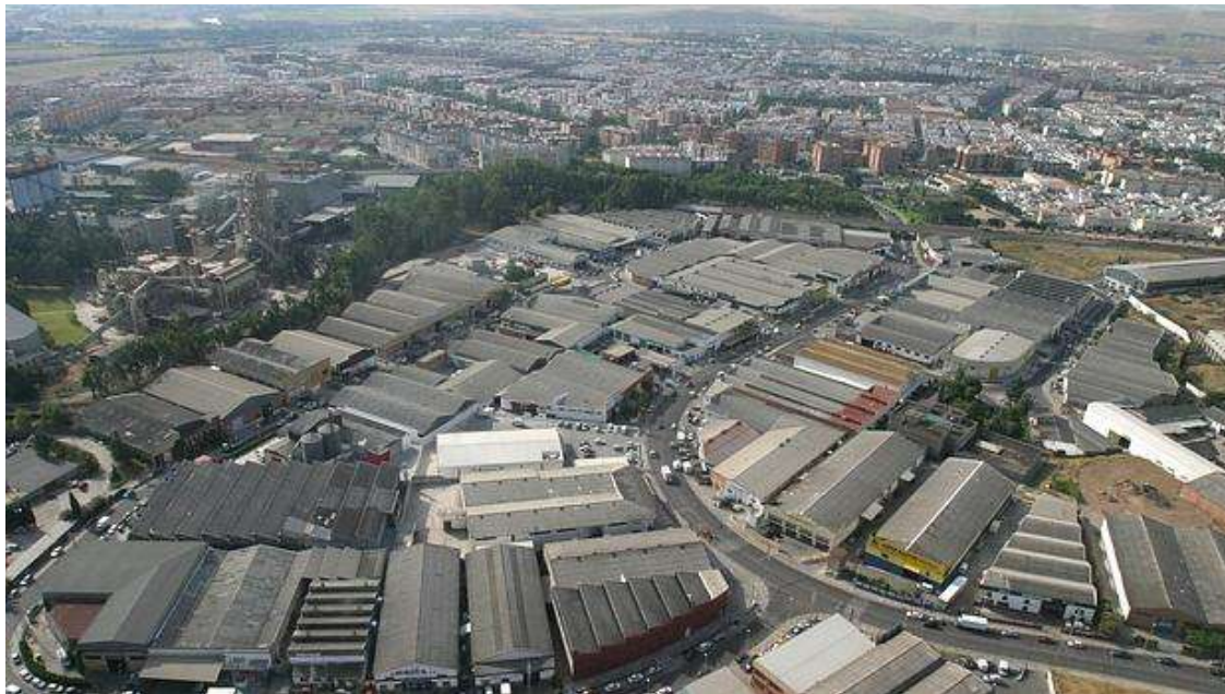
Vista aérea de Córdoba, Polígono de Chinales
