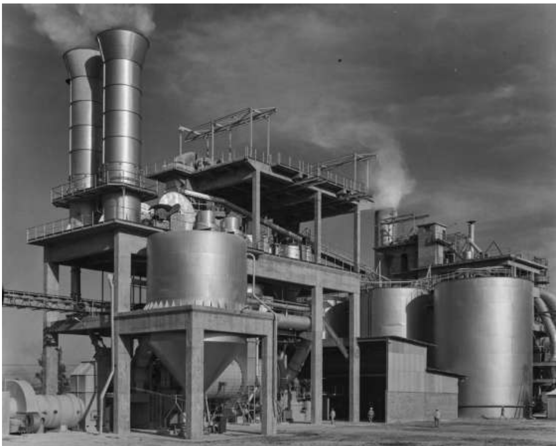
Vista general de las instalaciones de la cementera Asland de Córdoba [Foto: Juan Miguel Pando Barrero (1915-1992), fechada el 5 de abril de 1966] 69
