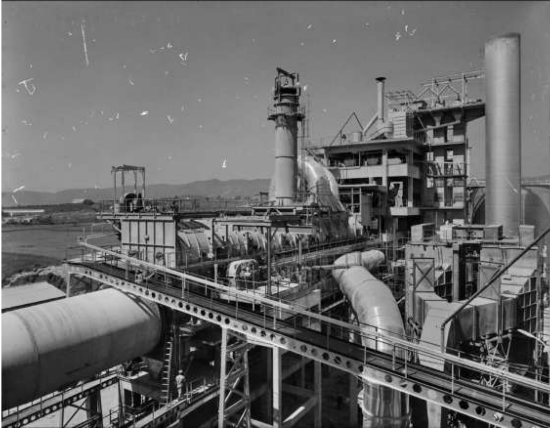
Vista general de las instalaciones de la cementera Asland de Córdoba [Foto: Juan Miguel Pando Barrero (1915-1992), fechada el 5 de abril de 1966] 68 .
