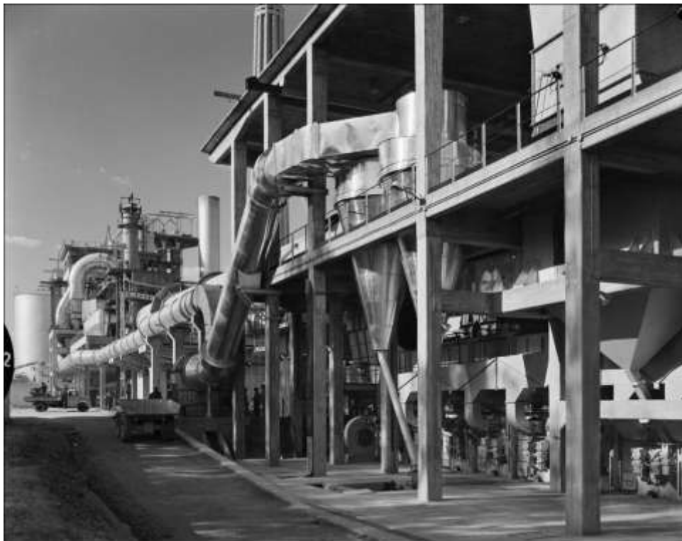
Vista general de las instalaciones de la cementera Asland de Córdoba [Foto: Juan Miguel Pando Barrero (1915-1992), fechada el 4 de abril de 1966] 54 .
