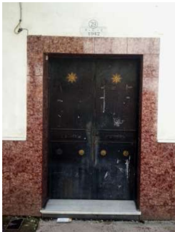
Puerta de la casa nº 29 de la C/ Granjuela (Zumbacón), fechada en 1942.
