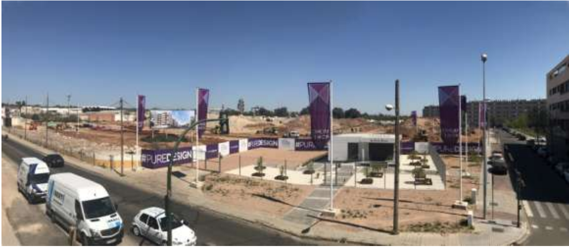
Obras de urbanización de los antiguos terrenos de la empresa Baldomero Moreno.
