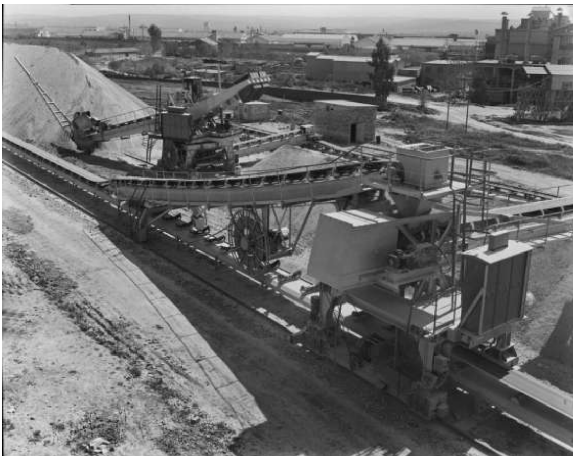
Vista general de las instalaciones de la cementera Asland de Córdoba (Foto: Juan Miguel Pando Barrero (1915-1992), fechada el 5 de abril de 1966) 101 .
