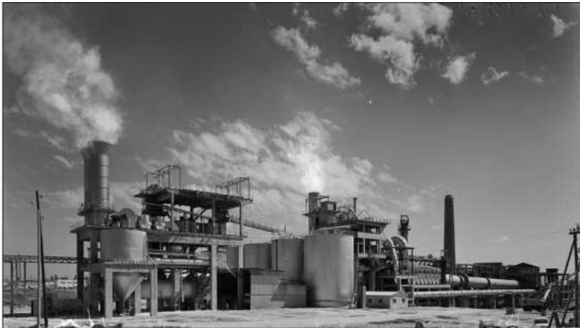
Vista general de las instalaciones de la cementera Asland de Córdoba [Foto: Juan Miguel Pando Barrero (1915-1992), fechada el 4 de abril de 1966] 53 .
