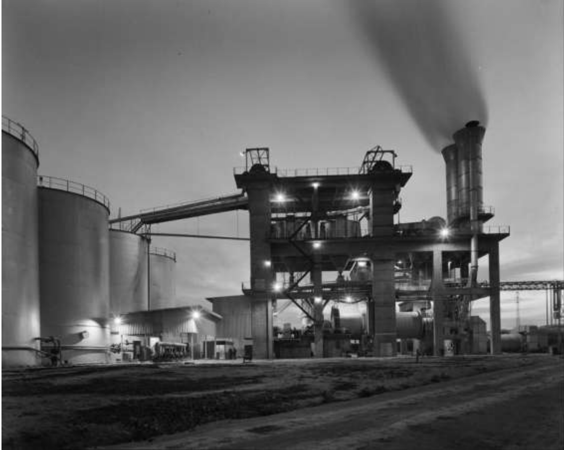
Vista general nocturna de las instalaciones de la cementera Asland de Córdoba [Foto: Juan Miguel Pando Barrero (1915-1992), fechada el 5 de abril de 1966] 62 .
