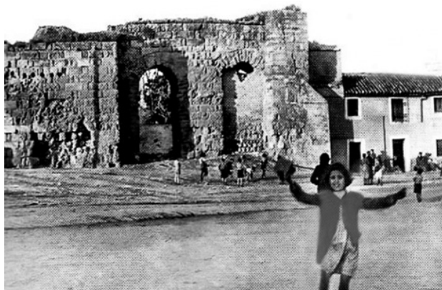
Torre albarrana en Puerta Sevilla
