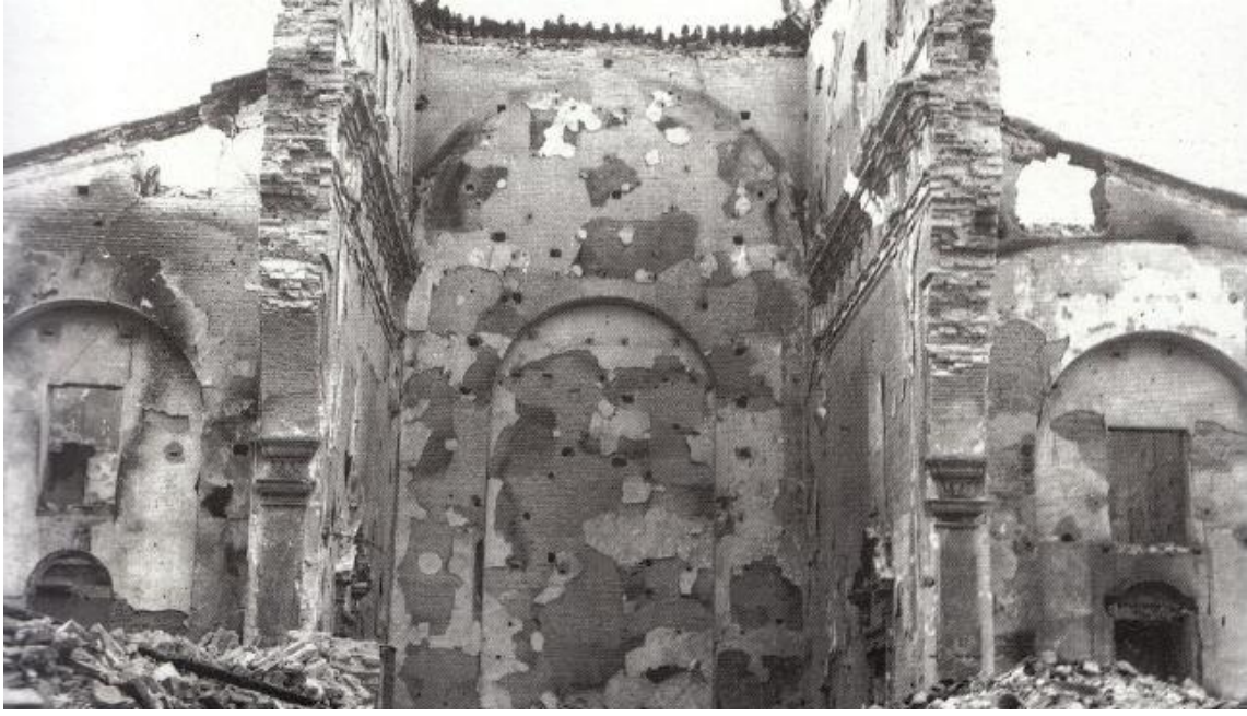
Así quedó la iglesia de San Roque
