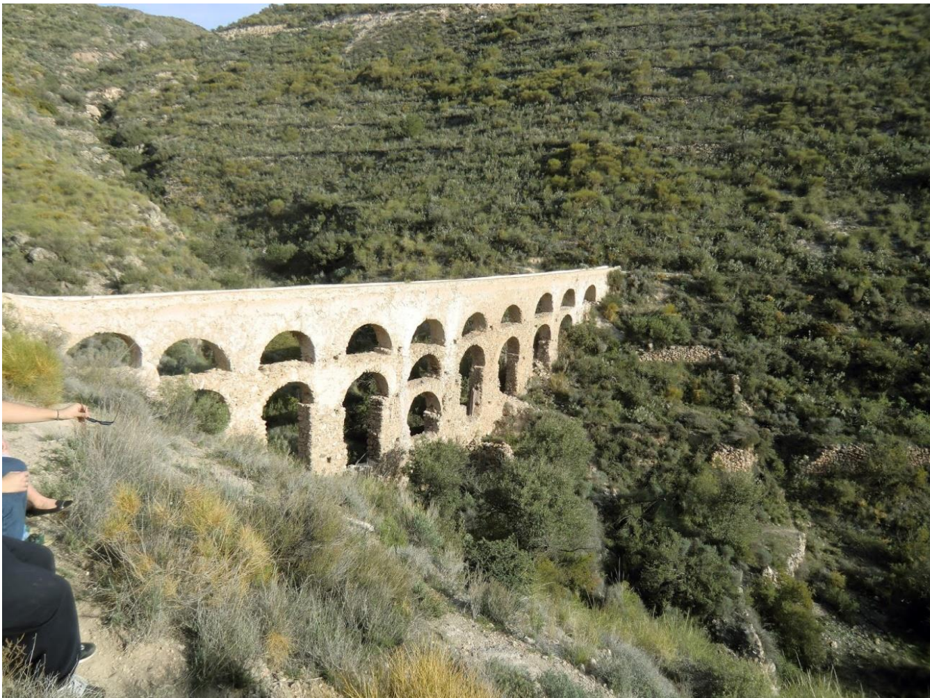
Puente de los Veinte Ojos. Carcauz (Almería)
