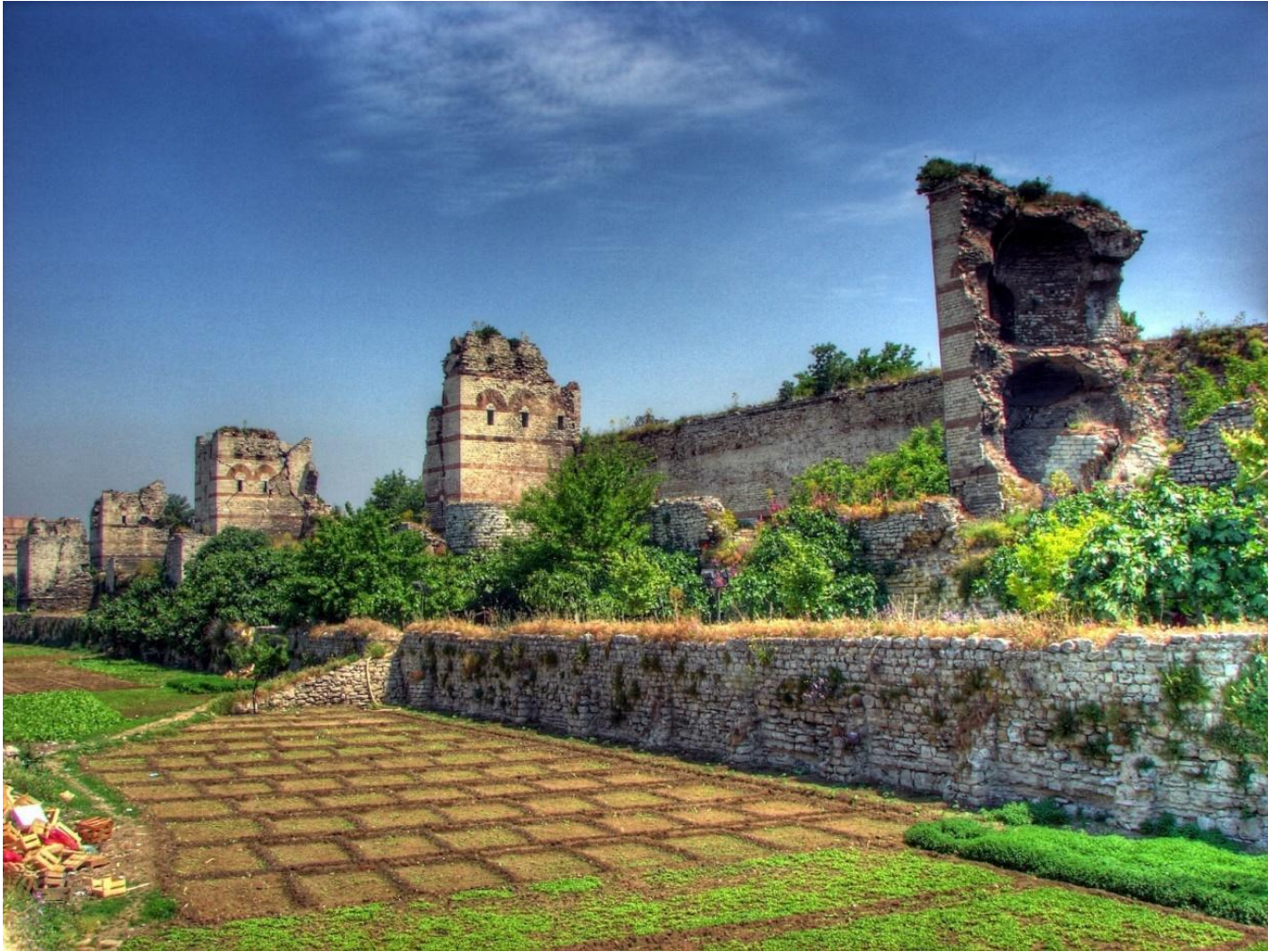
Las Murallas Teodosianas, antes de su restauración
