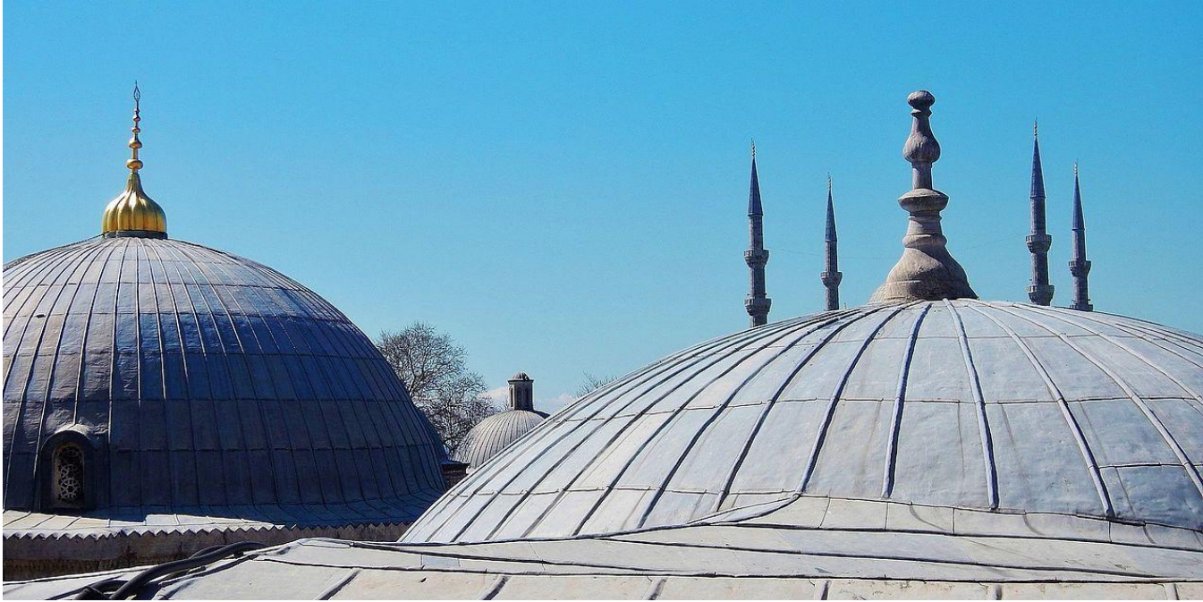
Cúpulas de Santa Sofía
