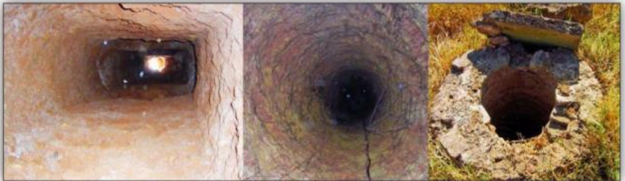
Formatos de lumbreras (interior y exterior)
