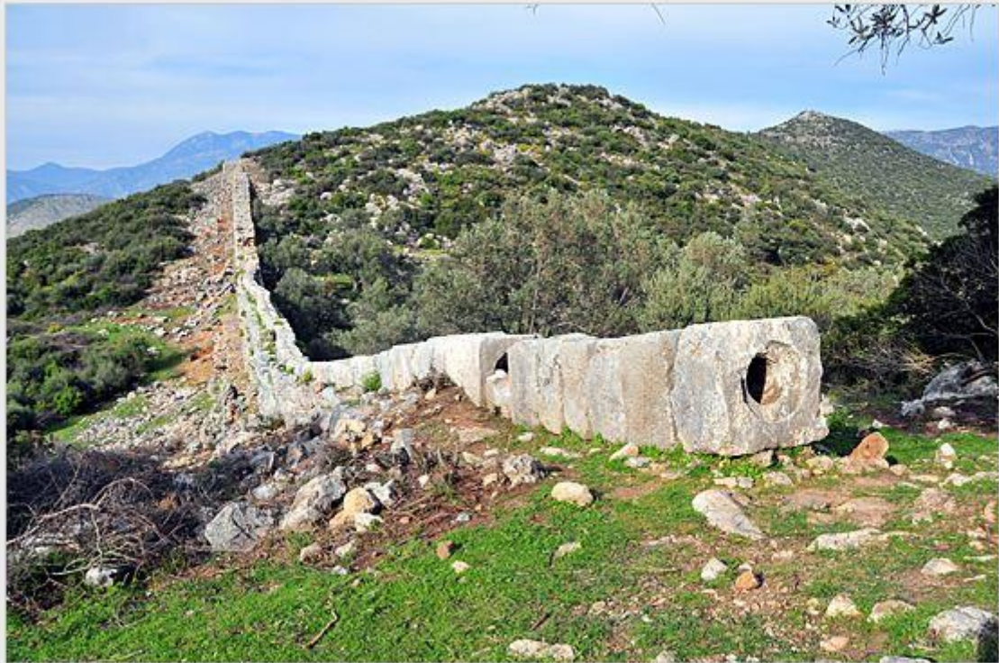
Instantánea del gran sifón de Patara (Turquía), con tubería de piedra. Foto: Isaac Moreno
