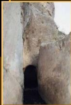
Acueducto excavado en roca
