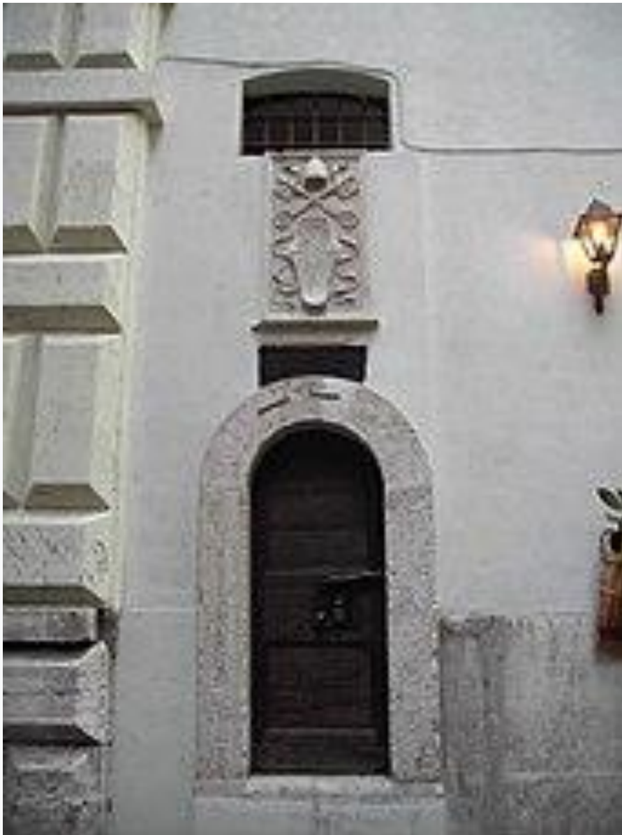
Entrada del canal de inspección al acueducto Acqua Vergine en la vía del Nazareno, en Roma (todavía operativo)
