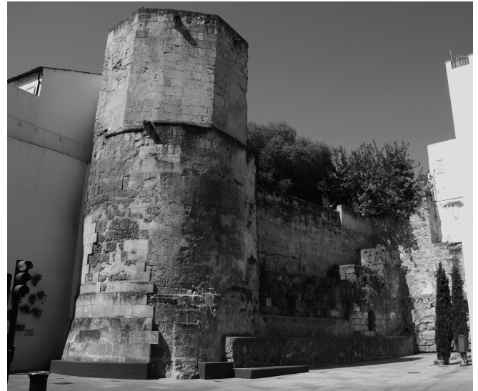
Restos de la murallas de la puerta del Rincón: al fondo, la cerca medieval sobre la que se asentaba la puerta y el torreón denominado “Mirador de los Capuchinos” y primer plano la torre de origen romano que cerraba el ángulo nororiental de la ciudad, sobre la que se eleva un recrecido medieval
