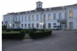
Antiguo Edificio de la Dirección de la SMMP Hoy geriátrico.
