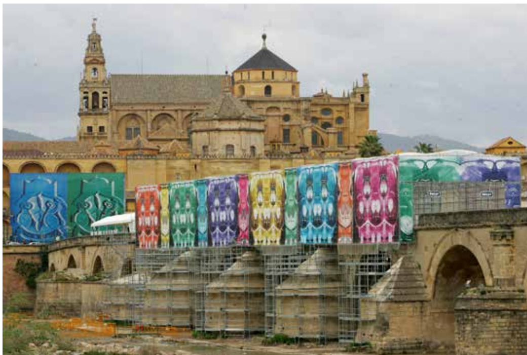
Restauración del Puente Romano. Antonio Jesús González. Imagen digital, 2006.
