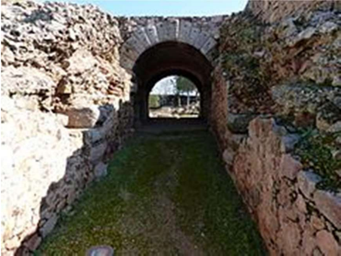
Túnel de acceso a la arena
