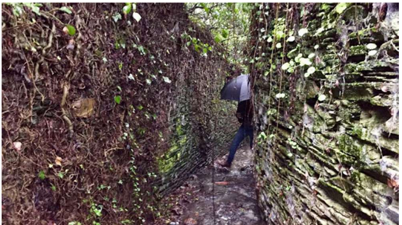
MUROS ACTUALES - FOTO: CARLOS CASTRO
