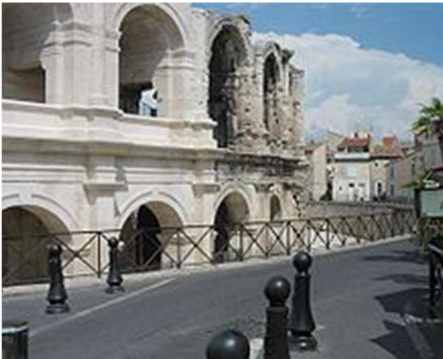
Trabajos de restauración en las Arenas de Arlés en el año 2006
