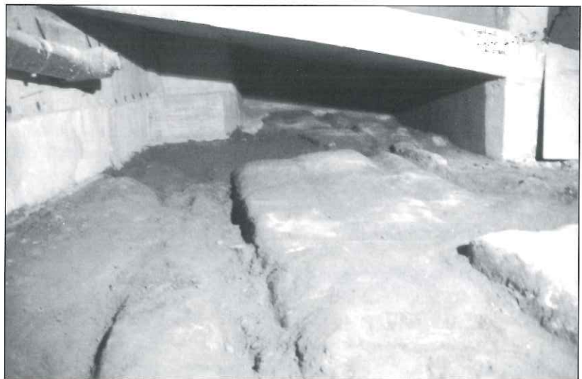
Lámina II.- Vista de la calzada.
