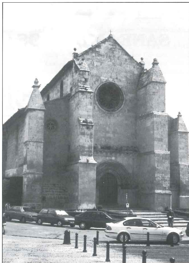
Iglesia de Sta. Marina. Fachada principal.
