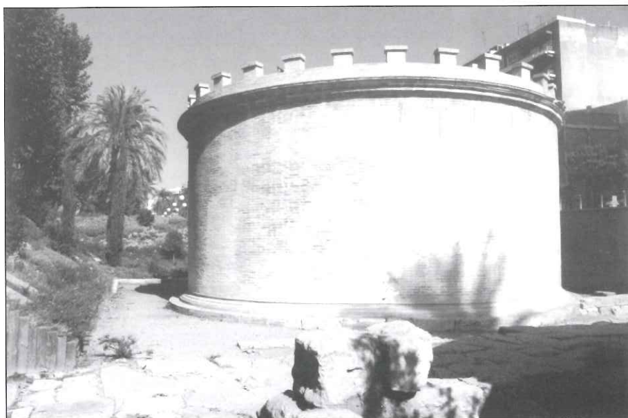
Tumba monumental romana de planta circular, situada frente a la Puerta de Gallegos, en Córdoba.
