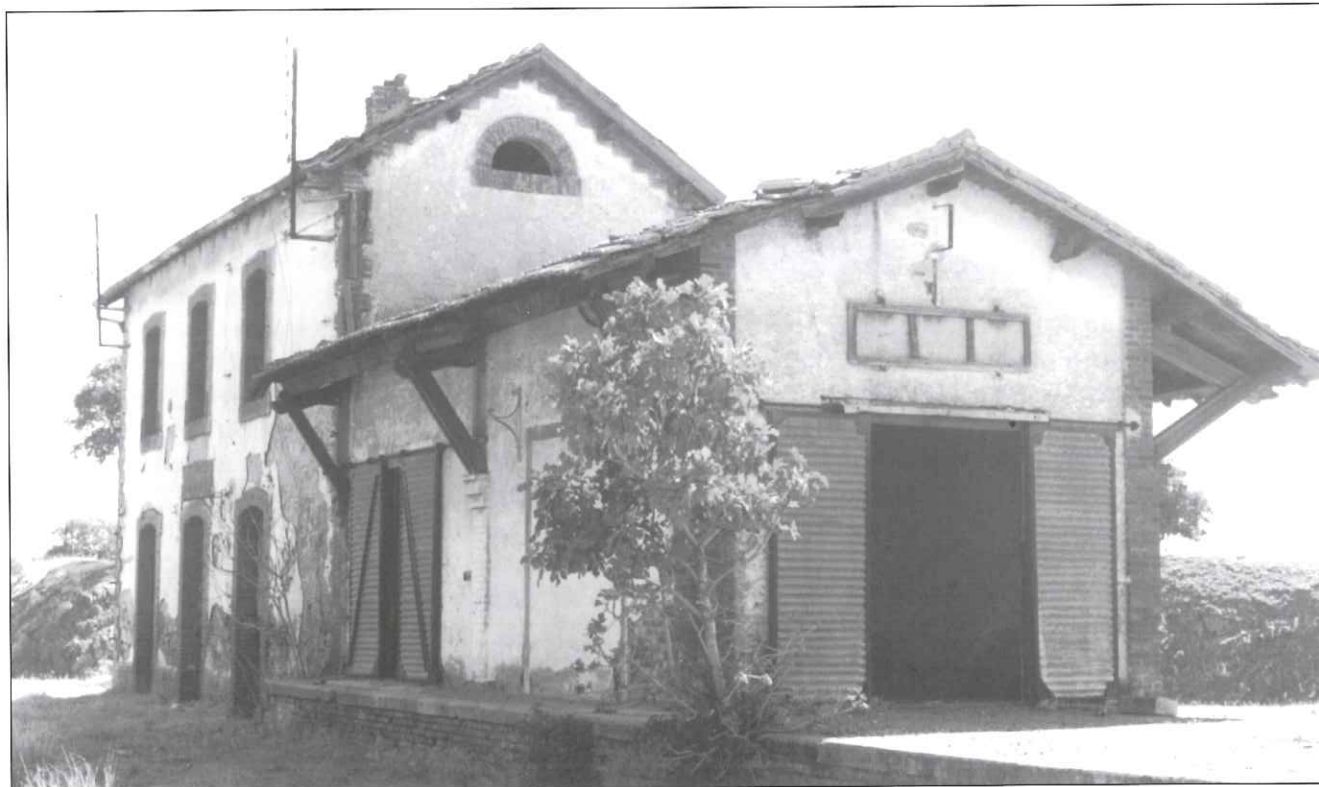
Estación del desaparecido ferrocarril de vía estrecha.
