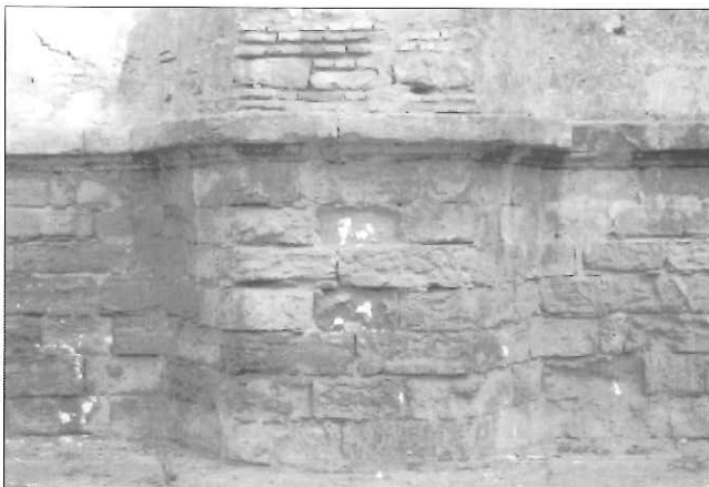
Fig. 5. Sillares a sustituir marcados con pintura blanca.
