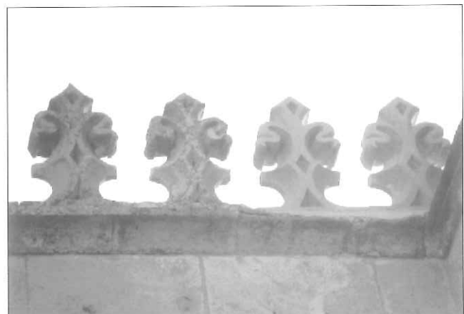
Fig. 7 y 8. Merlones y ménsulas reintegrados en la Mezquita-Catedral.
