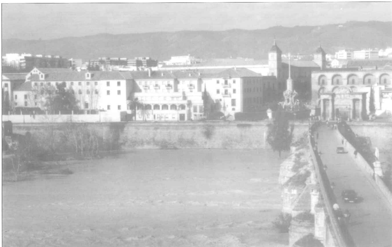
Cuando los musulmanes llegaron a Córdoba el viejo puente romano estaba prácticamente destruido.
