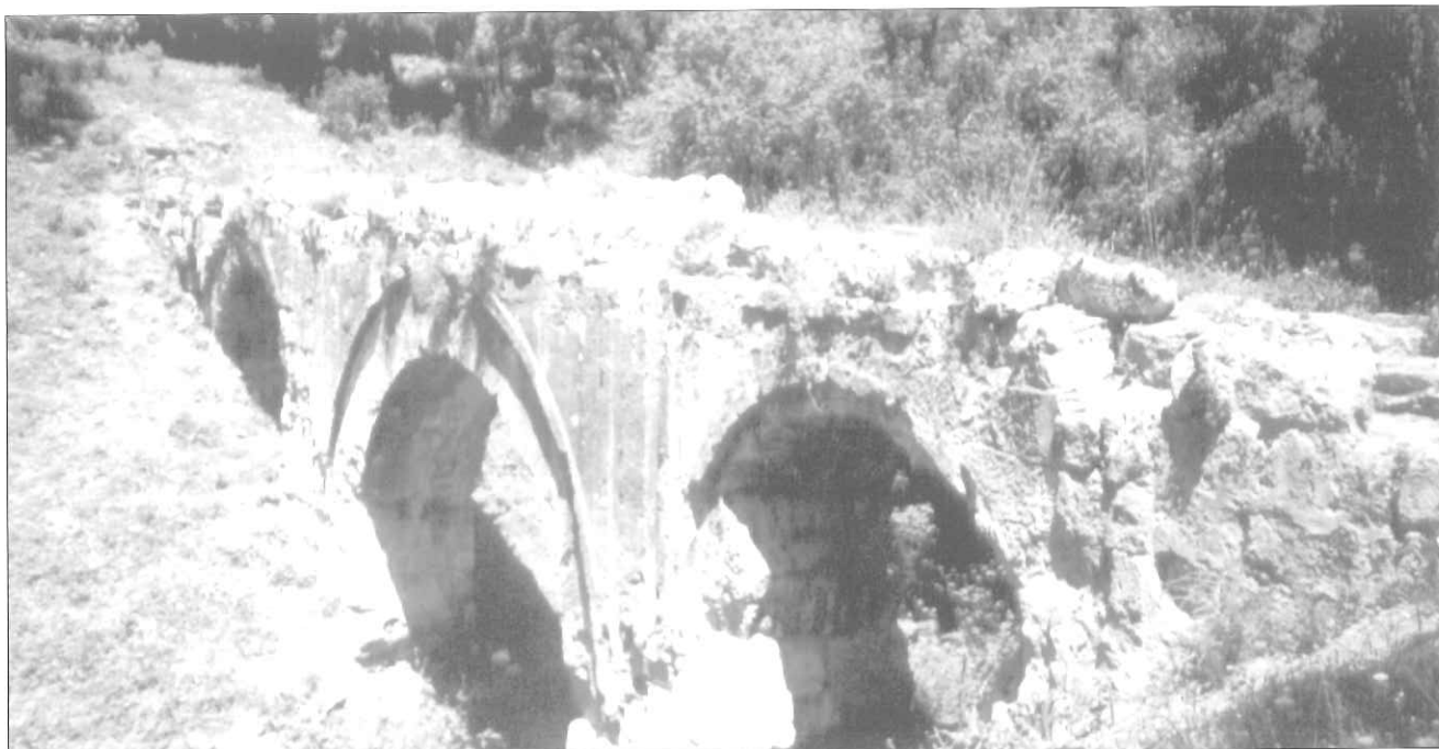
Fig. 4. Acueducto de Valdepuentes.
