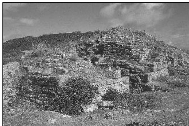
Fig. 6. Puerta de acceso al interior del recinto fortificado, abierta en el lienzo meridional, protegida por doble torreón de planta cuadrada
