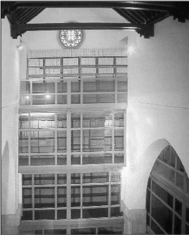
Depósito instalado en la antigua Iglesia de Santo Domingo de Silos del siglo XIII
