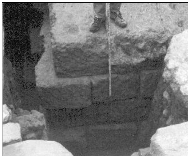
Lámina VI. Detalle de la anterior: aparejo de la sillería a tizón
