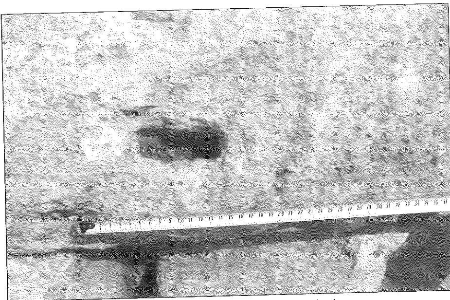
Figura 4: Detalle de una de las muescas de izado
