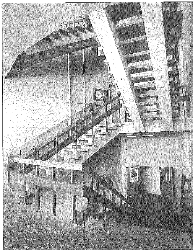
Rellano de una de las escaleras. Destacar la ejecución del hormigón visto en las tablillas de la cubierta
