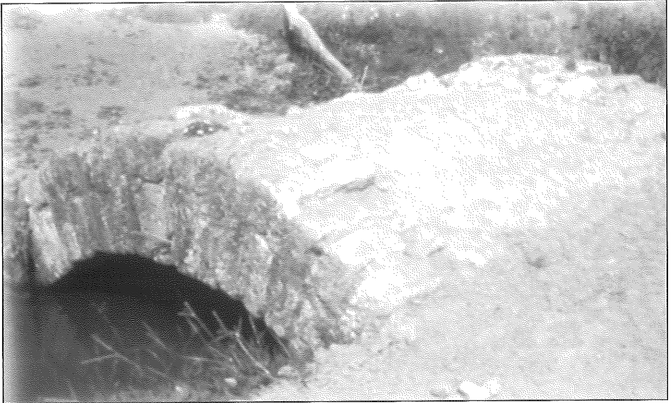
Figura 6: Vista General del puente desde el oeste.
