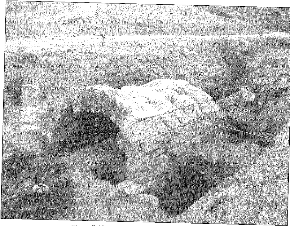
Figura 5: Vista General del puente desde el oeste.
