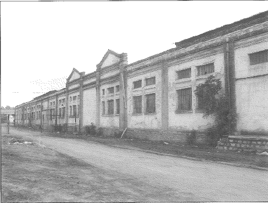
Exterior del conocido como "muelle de expediciones", en el conjunto de la Electromecánicas (Córdoba)
