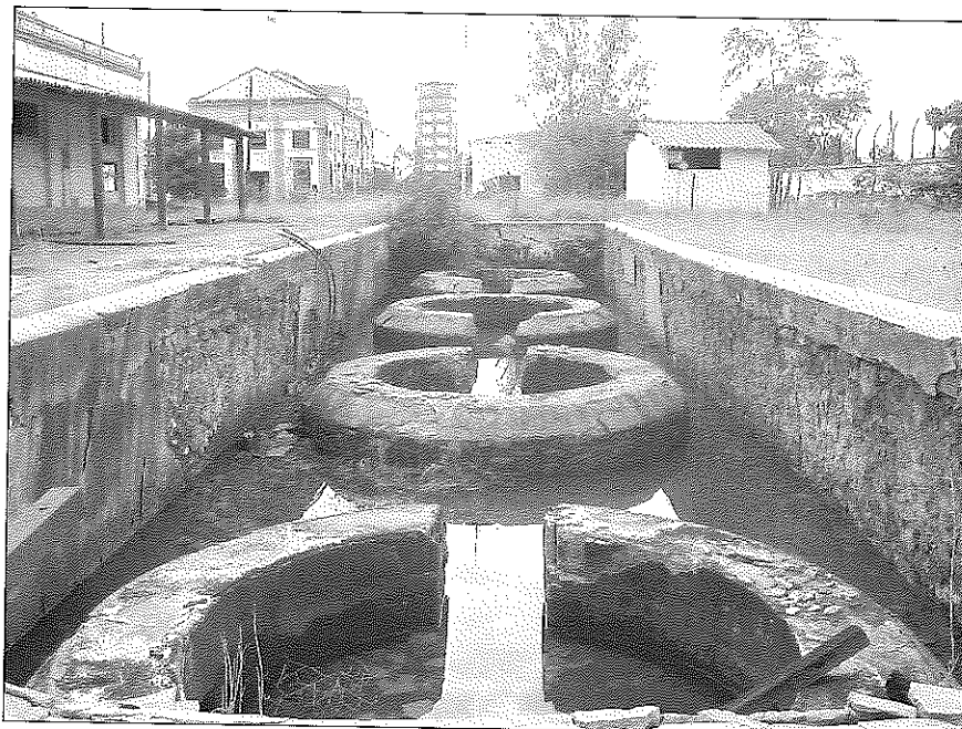
Cimentación de los depósitos de fuel para el funcionamiento del generador alternativo de corriente, en la antigua Electromecánicas
