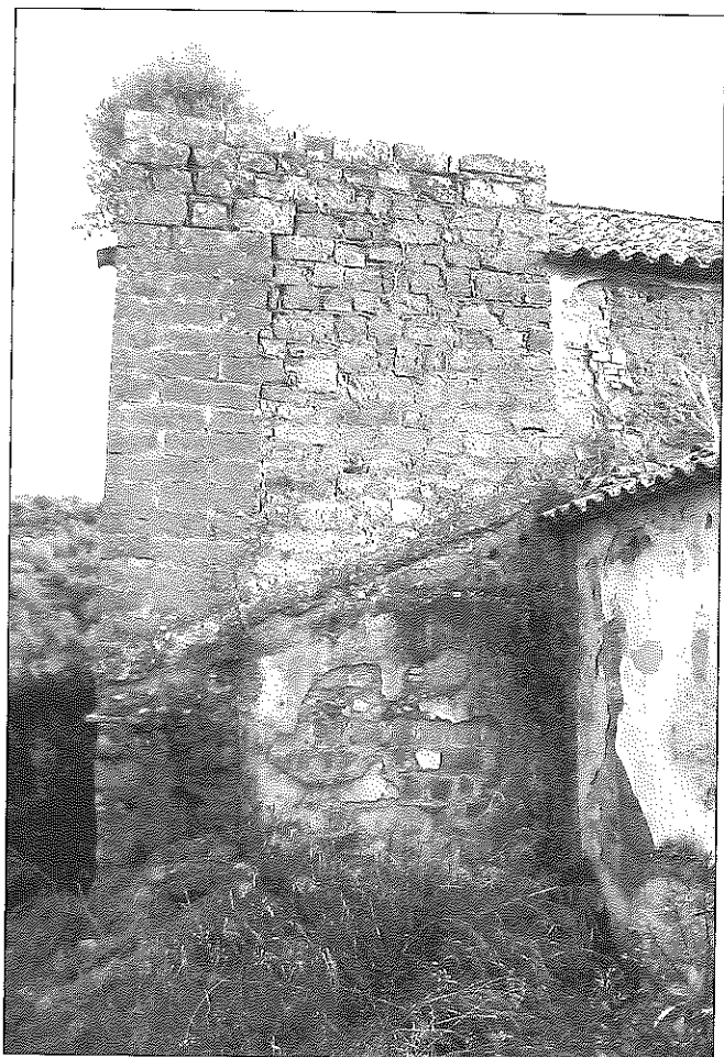
Figura 5: Vista de la torre desde el oeste
