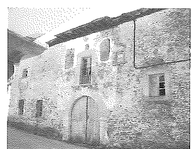
6. Murias de Paredes. Vista de la Casona de los Álvarez Carballo.
