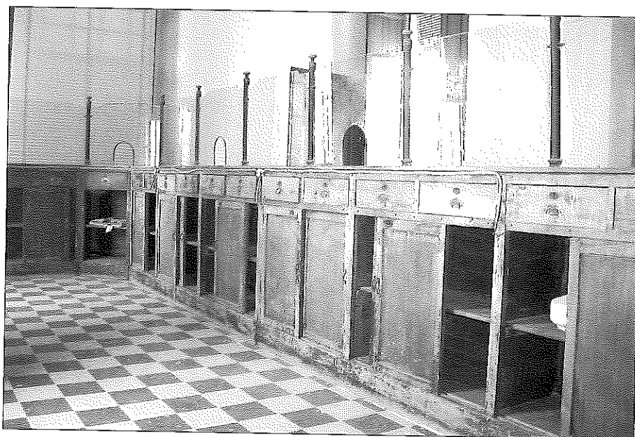
Interior de las oficinas de La Alianza, en Puente Genil, ejemplo de la potencialidad de este Patrimonio
