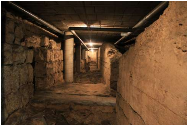
Detalles de la doble muralla que se encuentra en el sótano del edificio de la Plaza de Colón nº 8 (Foto: J. Padilla)
