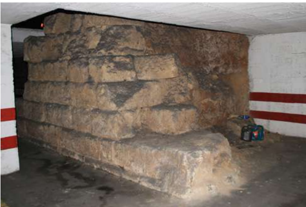
Cuatro vistas de la torre existente en los sótanos de Colón 9 (Fotos: J. Padilla)
