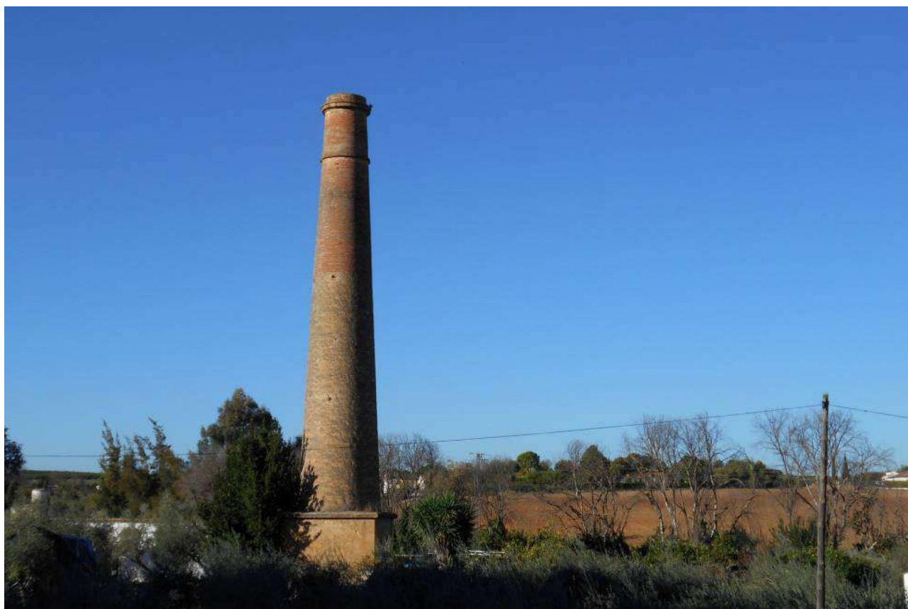
Lámina VIII. Chimeneón de la Fundición La Luz (Foto: Atanasio Moreno Villarreal)
