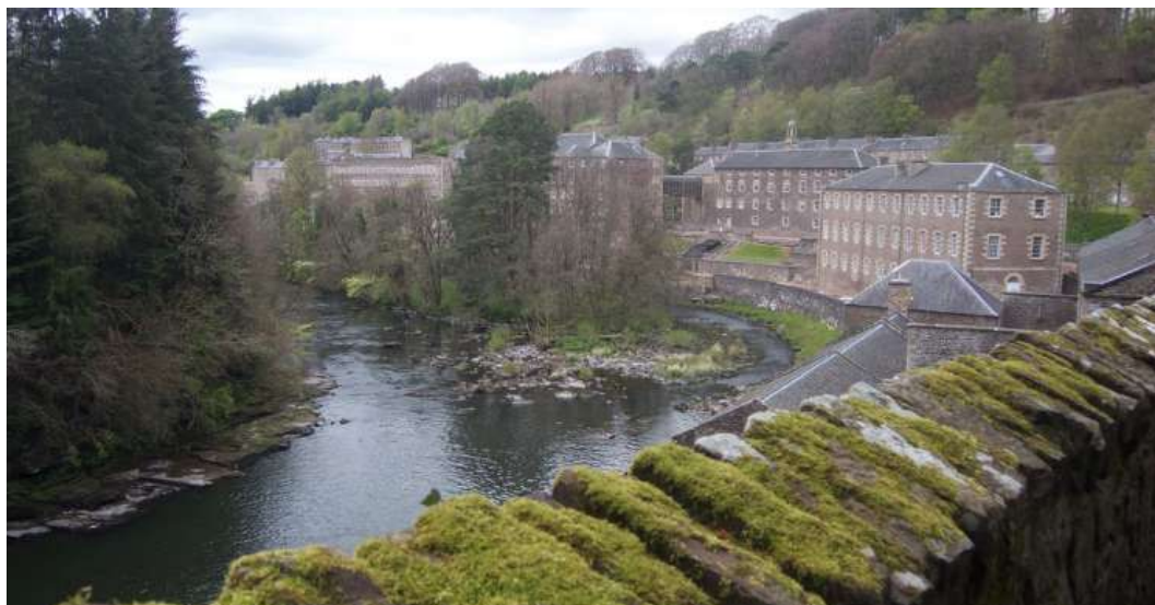
Fig. 5: Vista de New Lanark y saltos del río Clyde que se aprovechaban como fuente de energía para hacer girar los molinos que impulsaban la industria textil
