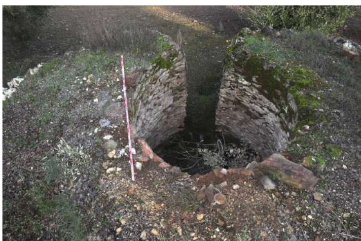
Lámina IX. Vista cenital de una de las caleras de Haza Gaspar
