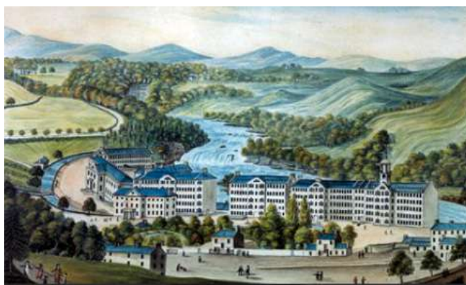
Fig. 9: Acuarela que muestra una vista de New Lanark realizada por John Winning en 1818 y que se empleaba para decorar los embalajes de las hiladuras producidas en New Lanark
