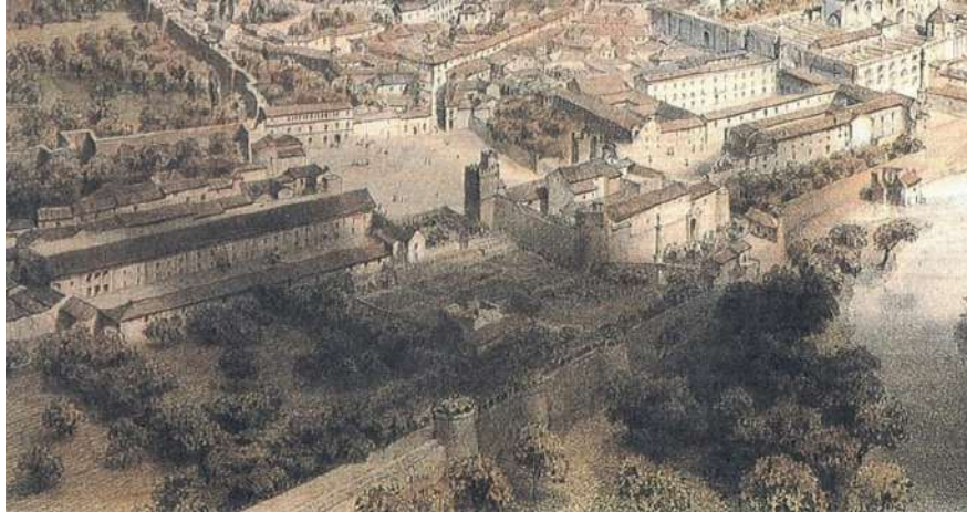
Fig. 3. Vista en detalle de la collación de San Bartolomé. Alfred Wesdon 1853
