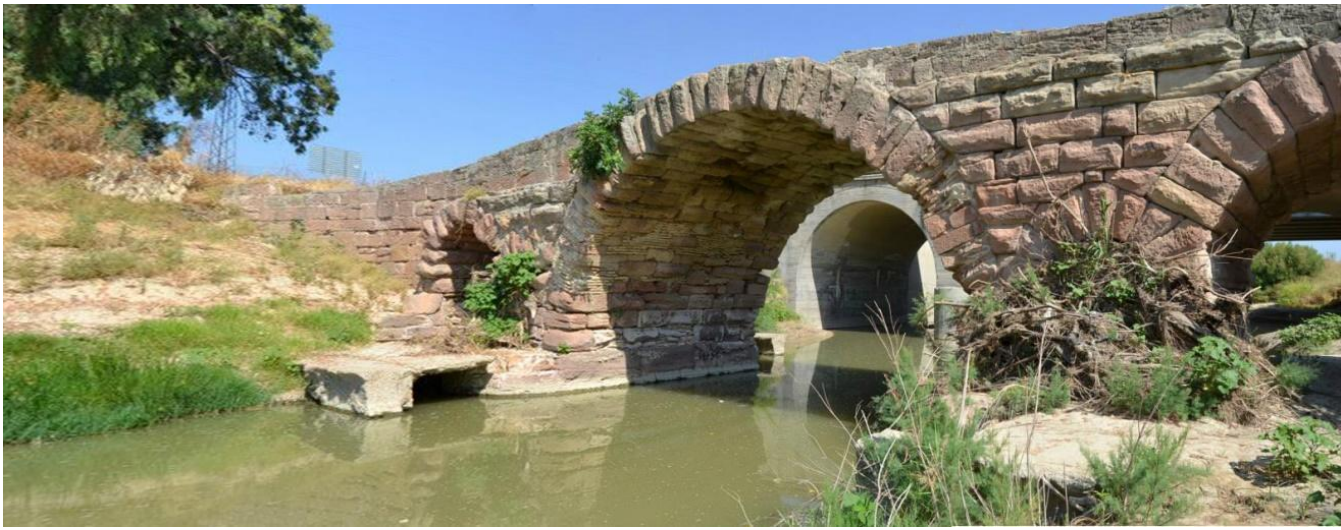
Puente sobre el Rio Salado en Villa del Rio (Córdoba)
