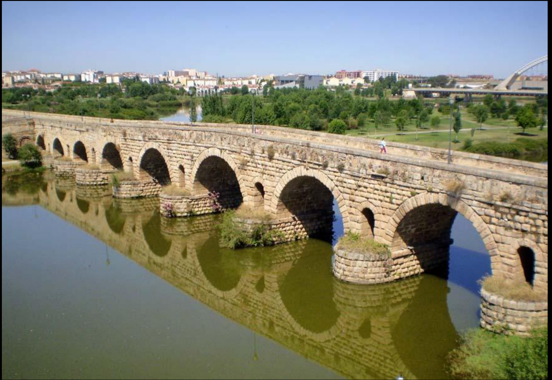
Puente romano de Merida
