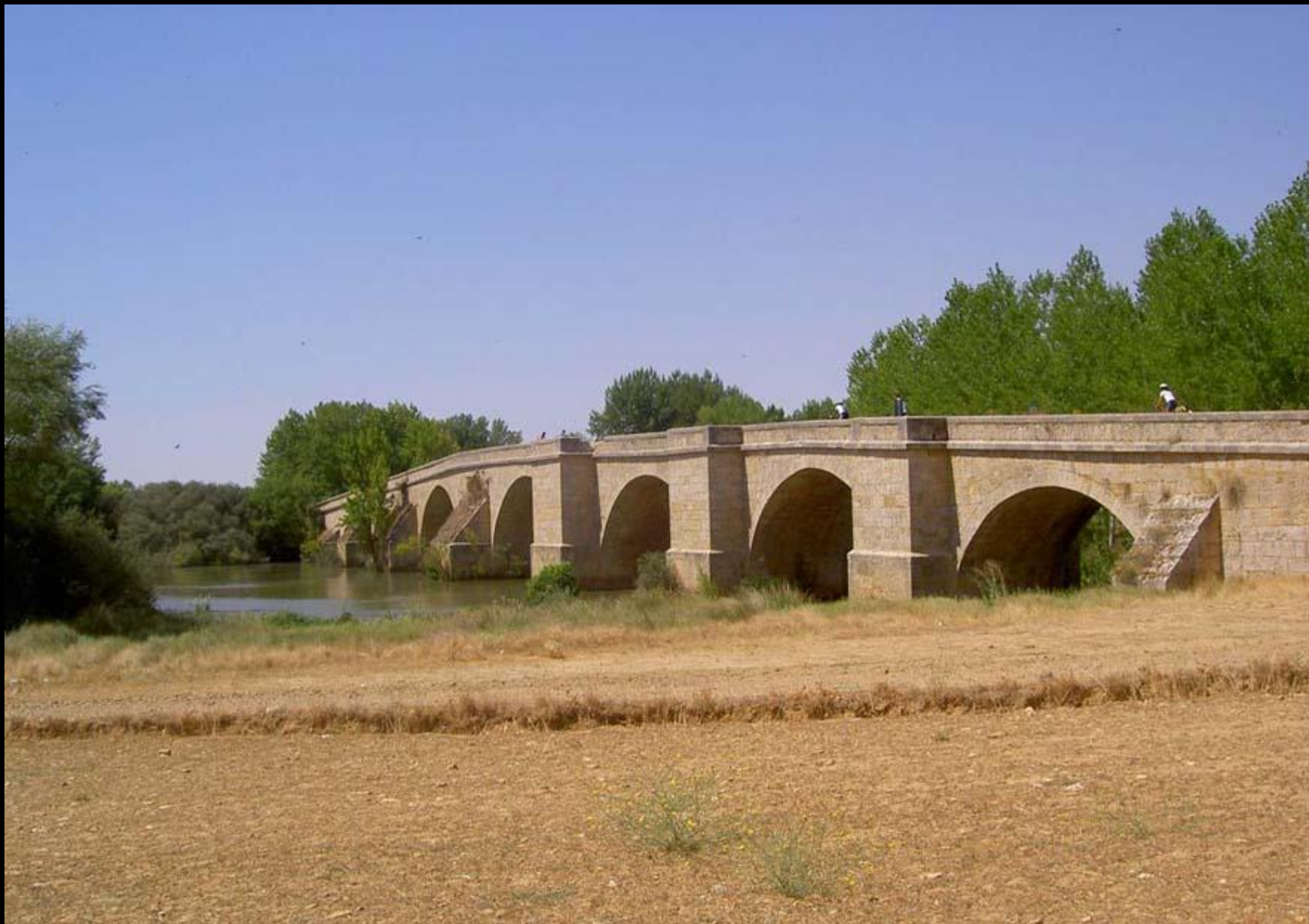
Puente de Fitero sobre el rio pisuerga (burgos)
