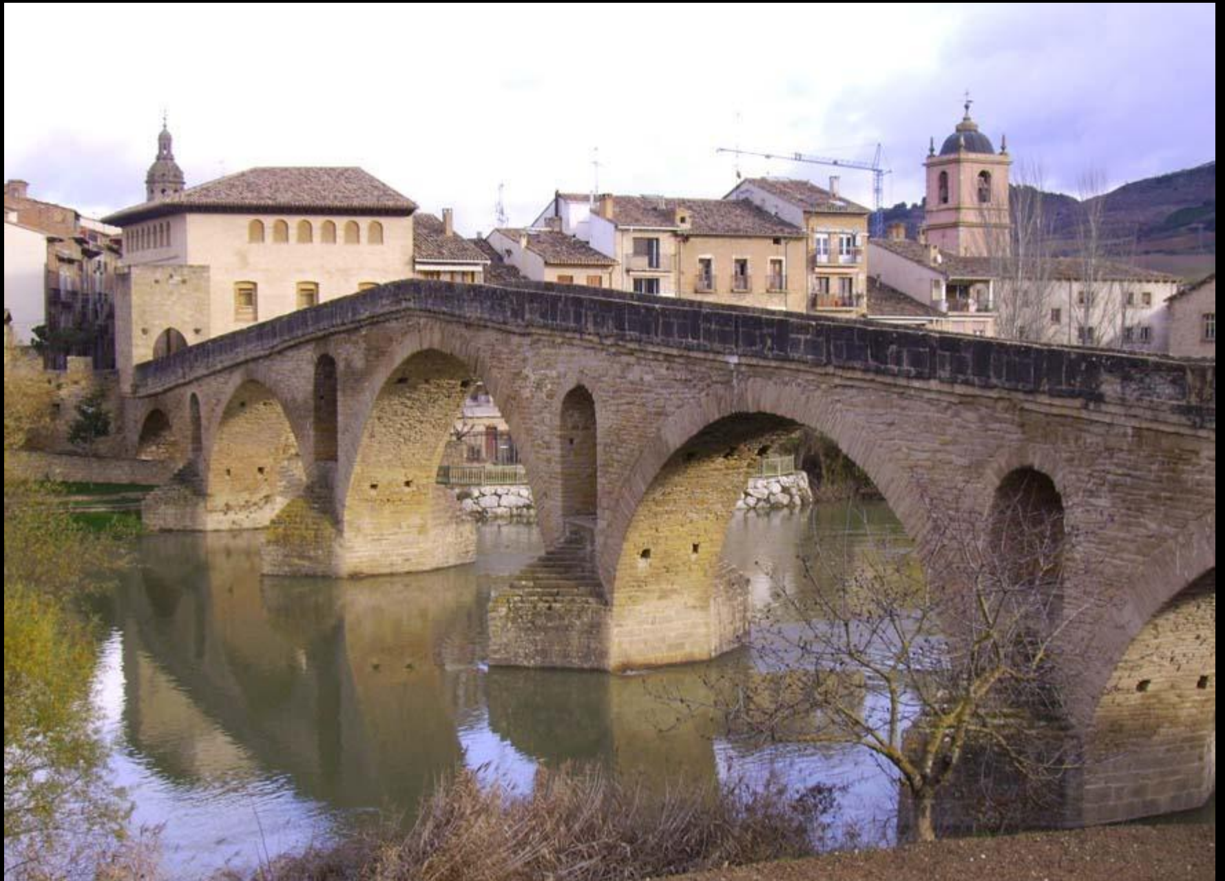
Puente románico de Puente la Reina (Navarra)
