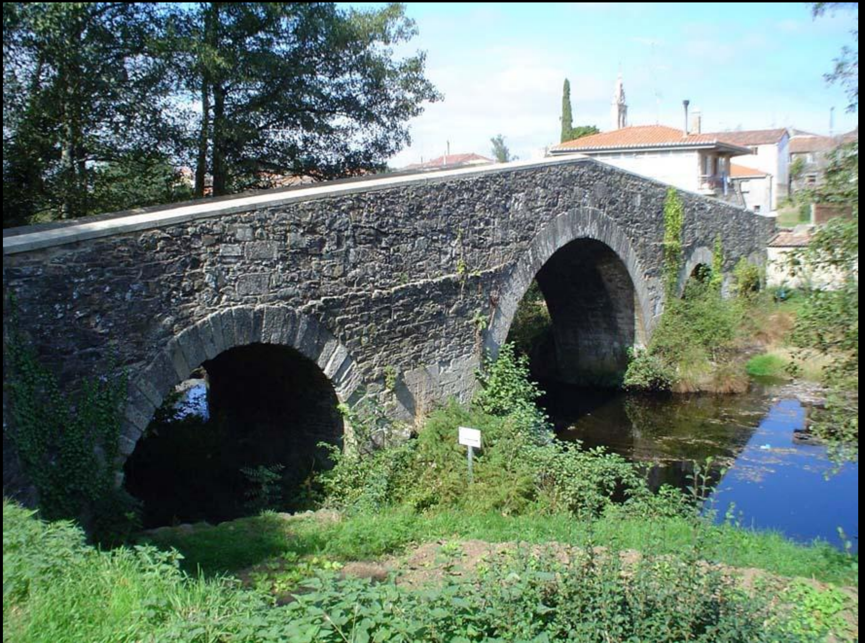
Puente romano de Furelos Paso obligado en el camino de Santiago
