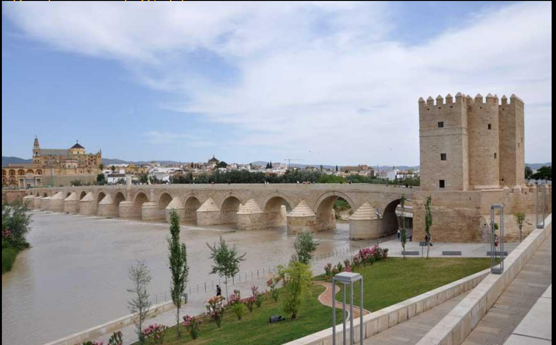
Puente romano de Córdoba
