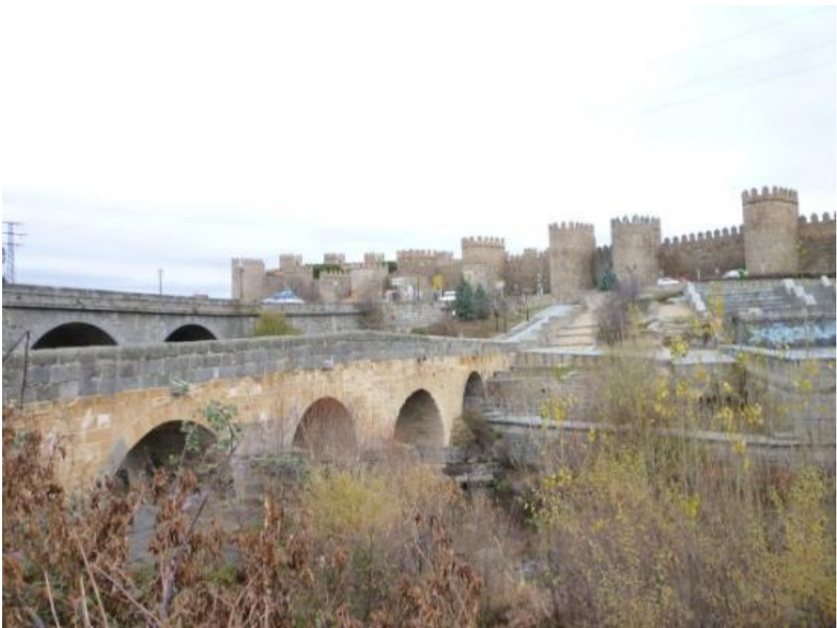
Puente romano de Ávila
