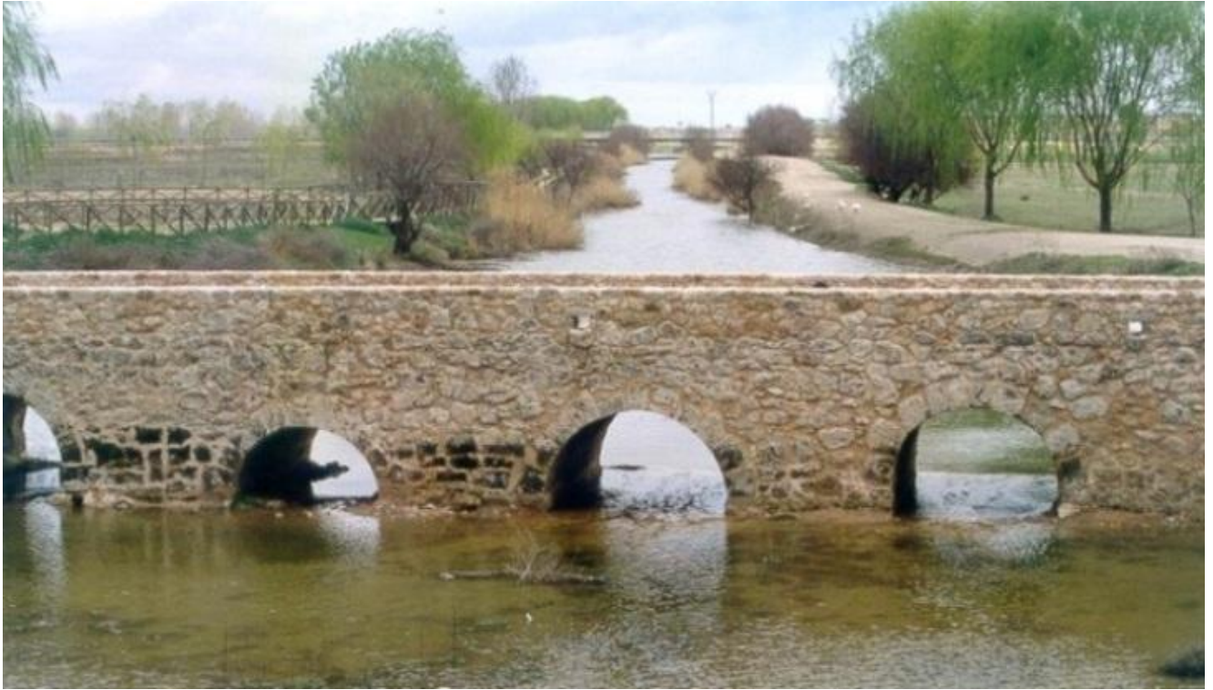
Puente romano de Villarta de San Juan (Provincia de Ciudad Real)
